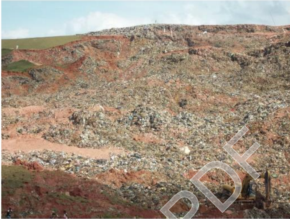
FIGURA 2 - RUPTURA DO ATERRO SANITÁRIO DE ITAQUAQUECETUBA, SP (2011)
