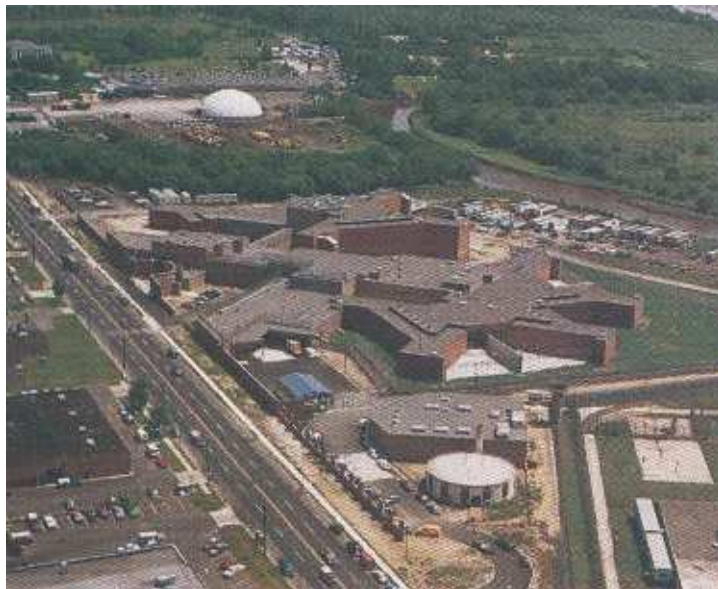
FIGURA 4.4.9 – Vista aérea, mostrando os blocos em Y, e as divisas, em como a área industrial em que se situa. (Fonte: ARCHITECTURAL RECORD. 1987)
