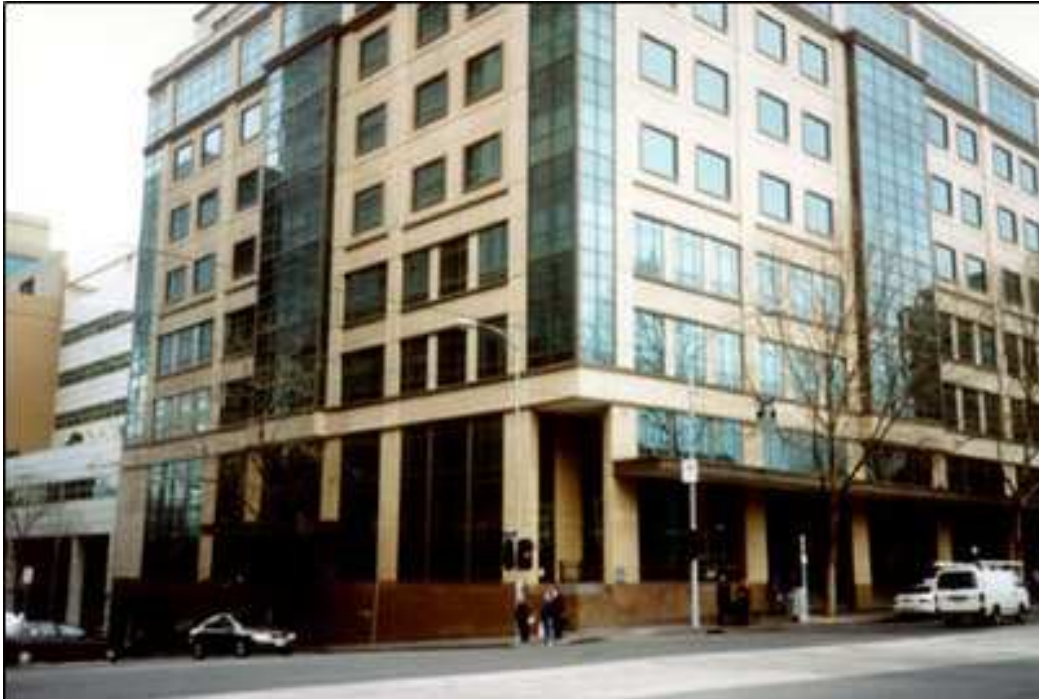
FIGURA 5.1.7 – Melbourne Custody Center, Melbourne, Victoria, Austrália (Fonte: GEO, 2007).
