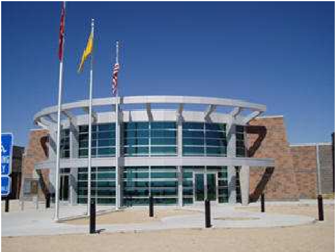
FIGURA 5.1.2 – Emprego de sistemas industrializados como estrutura metálica, vidros, tijolos e blocos de concreto pré-moldado. Bernalillo County Metro Detention Center, Albuquerque, Novo México, EUA. (Fonte: BONDED, Miller, 2007).
