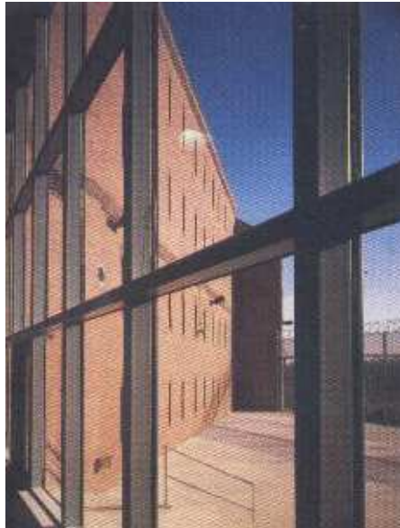
FIGURA 4.4.6 – Abertura com a vista para o pátio e o detalhe da esquadria. (Fonte: ARCHITECTURAL RECORD. 1987)
