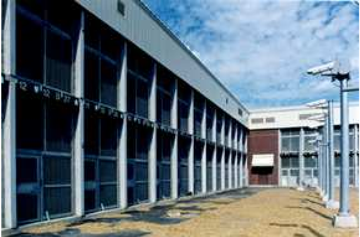
FIGURA 5.1.3 – Penitenciária de segurança máxima com celas pré-moldadas em concreto diminuem o tempo de execução, com alta durabilidade e baixo custo de manutenção. Five Points Maximum Security, Romulus, NY, EUA (Fonte: OLDCASTLE PRECAST MODULAR GROUP, 2007).
