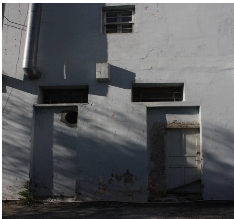
Figura 5.29 – Vista da atual entrada lateral de serviços do estacionamento (Fonte: Autora, 2013).
