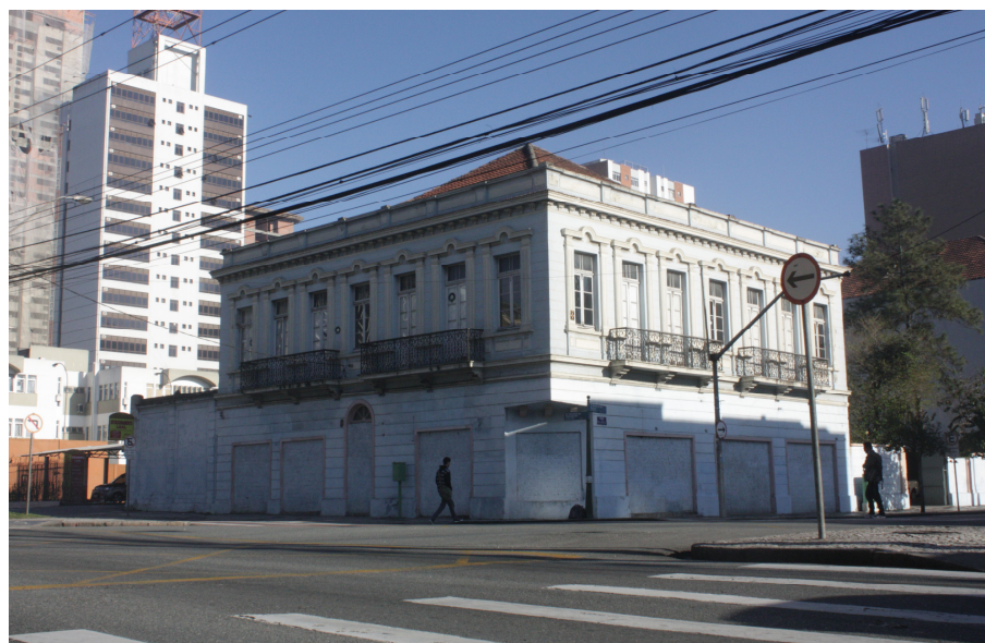
Figura 5.21 – Vista atual da casa Casa Cel. Agostinho Souza, Curitiba PR (Fonte: Autora, 2013).
