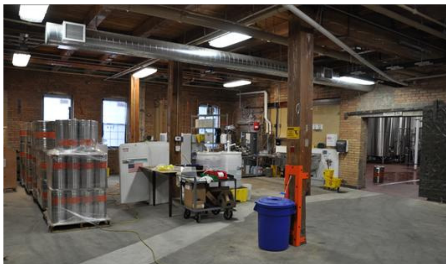
Figura 4.22 – Vista da sala de envase da Indeed Brewing (Minneapolis MN, EUA) (Fonte: MNBEER, 2013).
