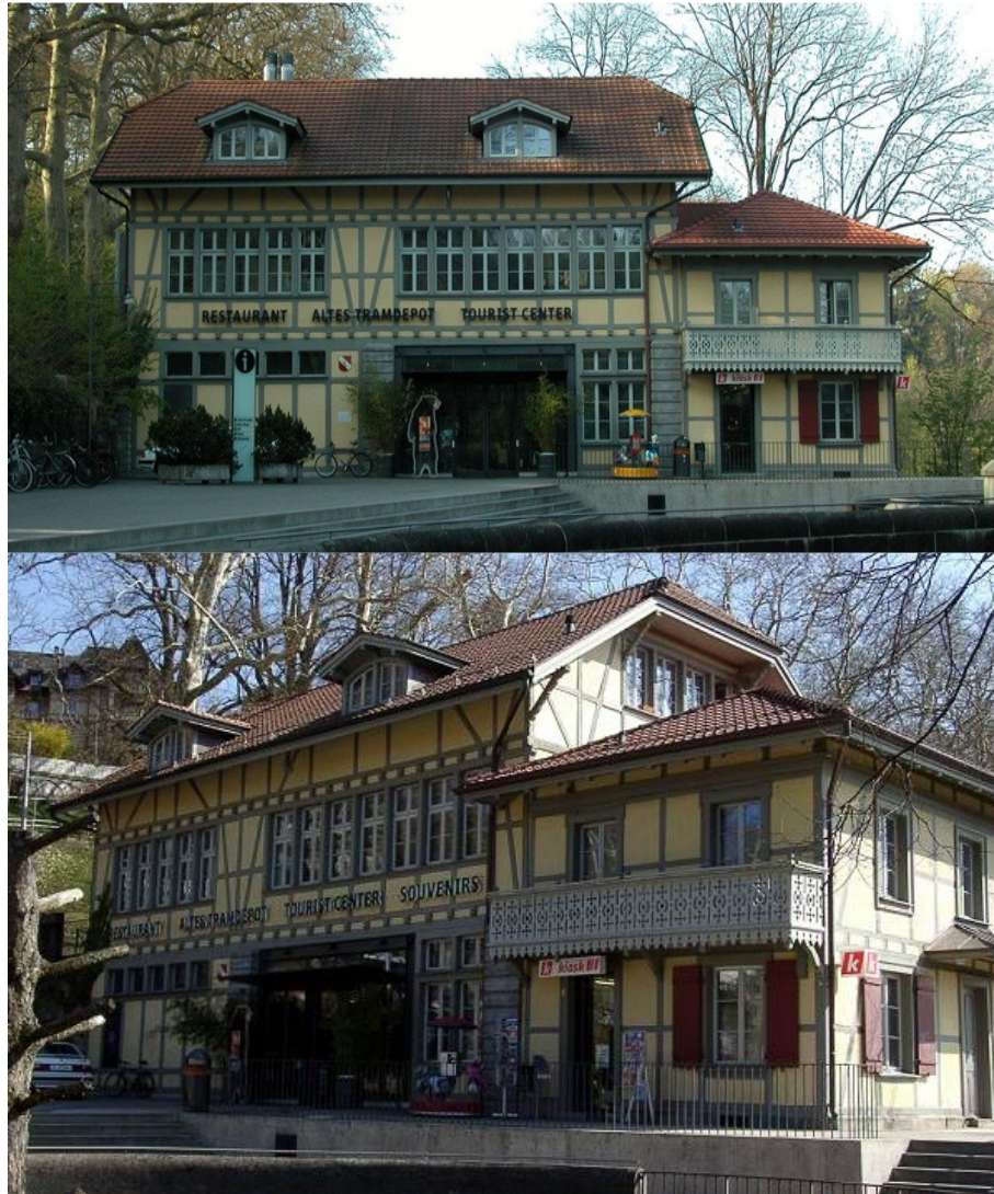
Figura 4.4 – Fachada frontal de Altes Tramdepot (Berna, Suíça) (Fonte: BERN, 2013; HAMPAGE, 2013).
