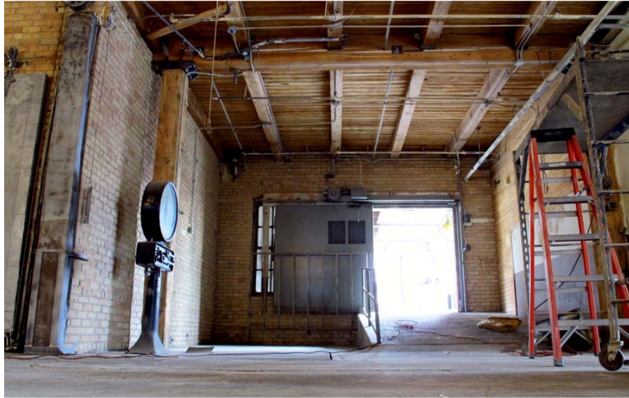
Figura 4.17 – Balança e porta corta-fogo originais (Minneapolis MN, EUA) (Fonte: SOLAR ARTS BUILDING, 2013b).
