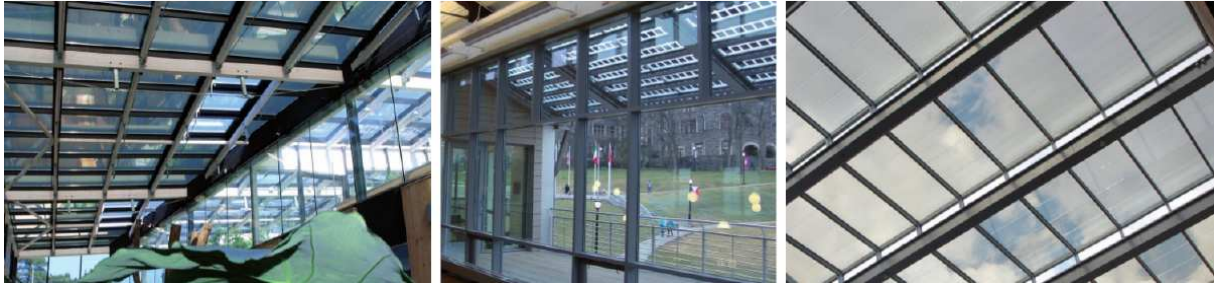
Figura 17: BIPV aplicado em coberturas e brises . Fonte: Onyx, 2013
