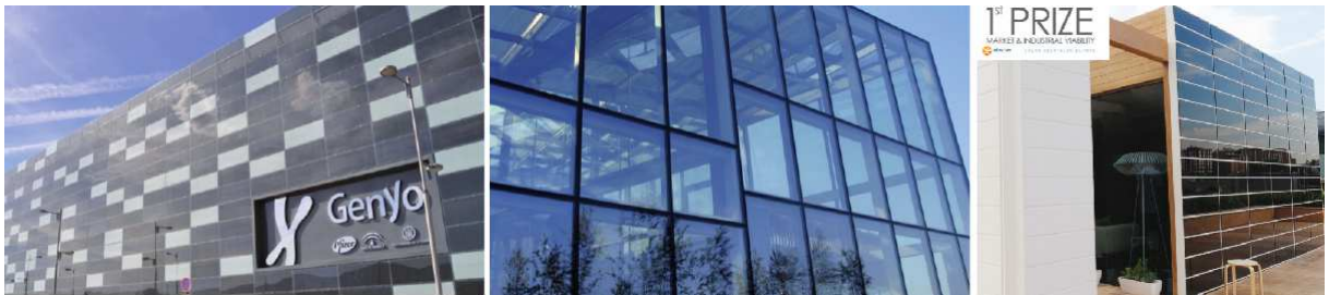
Figura 18: BIPV aplicado em fachadas . Fonte: Onyx, 2013
