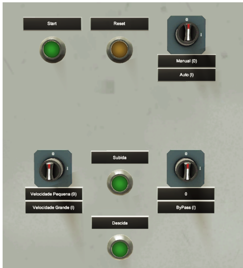
Figura 37 - Quadro elétrico do ambiente de simulação
