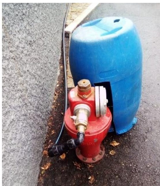
Figura 12: Exemplo de uma ilicitude encontrada pela empresa Águas de Gaia, EM,S.A com marcos de incêndio.
