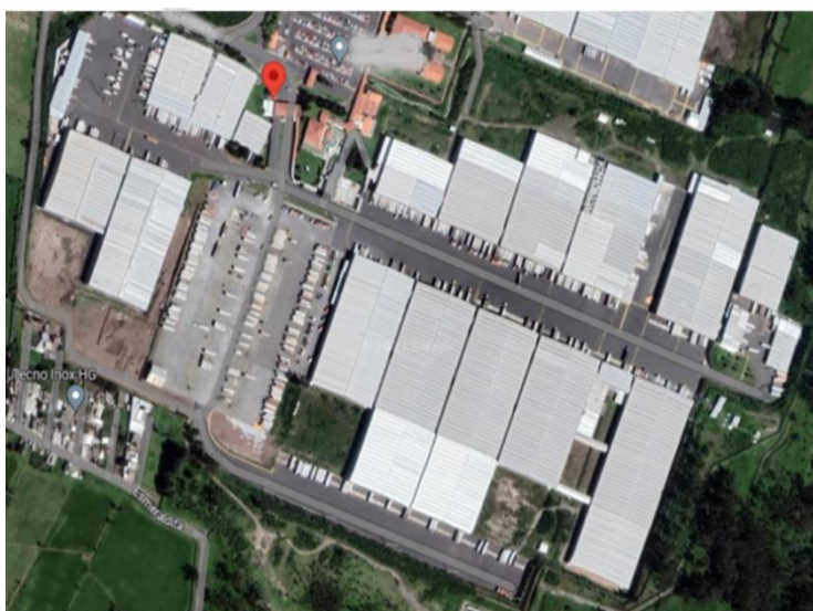
Figura 8. Vista satelital bodegas de la empresa.
