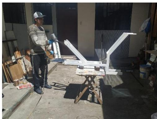
Figura 66. Proceso de recubrimiento anticorrosivo
