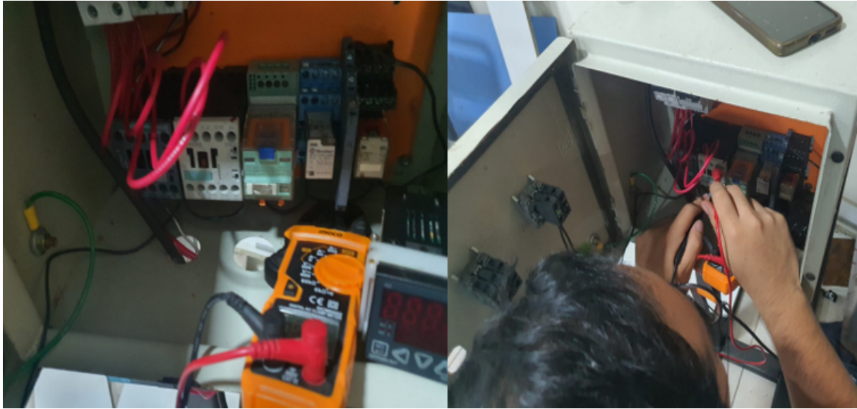
Figura 73. Conexión de tablero eléctrico.
