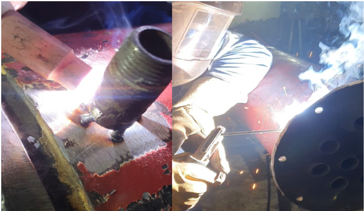
Figura 78. Soldadura en Caldero.
