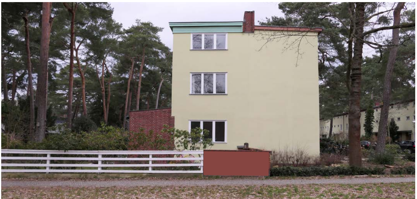
Giebelfassade eines Reihenhauses von Hugo Häring.
