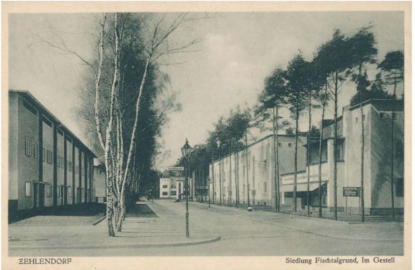
1929 | Blick in die Straße im Gestell mit den Reihenhäuser von Rudolf O. Salvisberg (linke Seite) und den Mehrfamilienhäuser von Bruno Taut (rechte Seite). Sandbirken als Straßenbäume auf der linken Seite und Kiefern des ehemaligen Kiefernforstes auf der rechten Seite.
