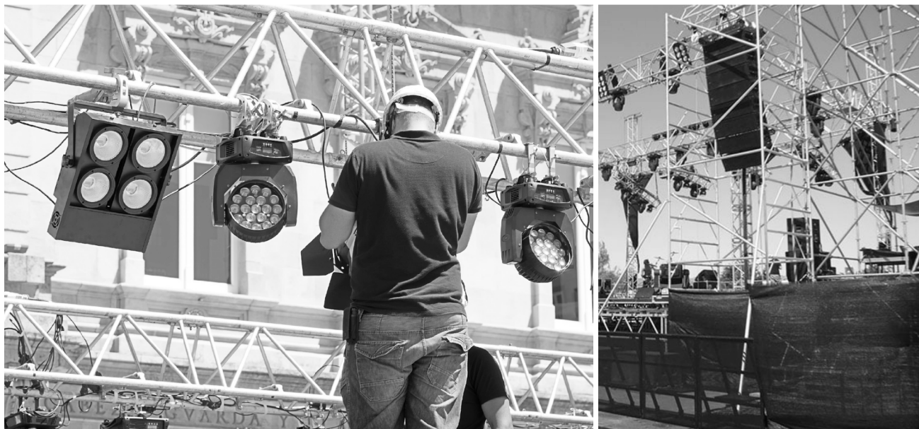
Imagen Ilustrativa 5.4 – Instalación de elementos de iluminación y sonido.
