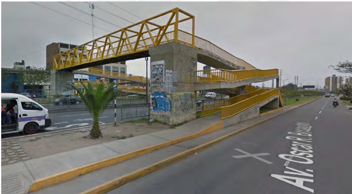
Figura 4.10. Puente al este de la intersección. Fuente: Google
