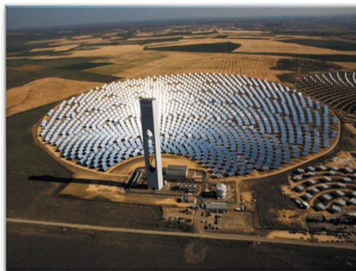
Figura 1.4.2.1.1: Torre solar en Sevilla, España de 10 MW de potencia.
