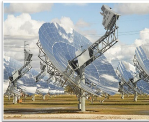
Figura 1.4.2.4.3: Sistema CSP con motor Stirling
