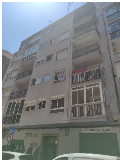
Figura 19. Fachada calle Alcocebre.
