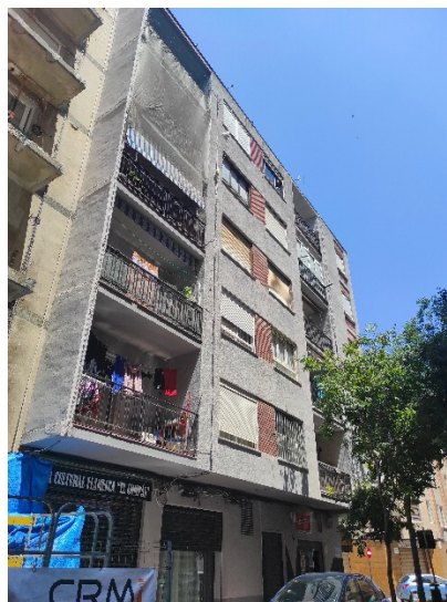
Figura 16. Fachada calle Gravina.
