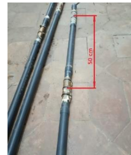
Figura 2: Distribución de los sensores a lo largo del tubo de PVC en los primeros 3 metros.
