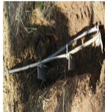
Gambar 4.1.1 Pemasangan Elektrode siku bracing
