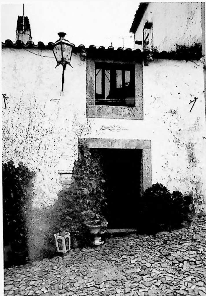
N.º 3 — Pormenor de arquitectura tradicional
