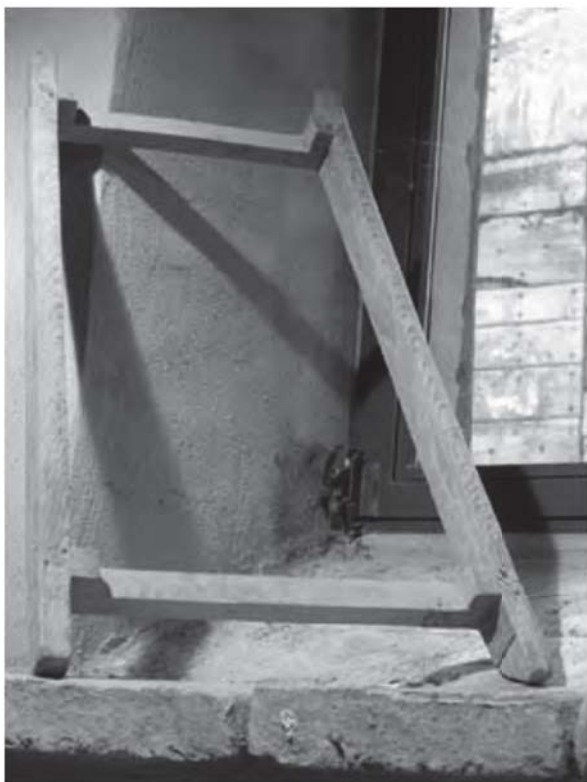
Slika 3.37. Rekonstrukcija kalupa za izradu tegula (prema: Shepherd 2006: 169, fig. 138.)
