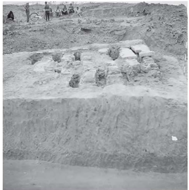
Slika 5.43. Oštećeni gornji deo peći 5 radionice 3 (dokumentacija Arheološkog Instituta u Beogradu)
