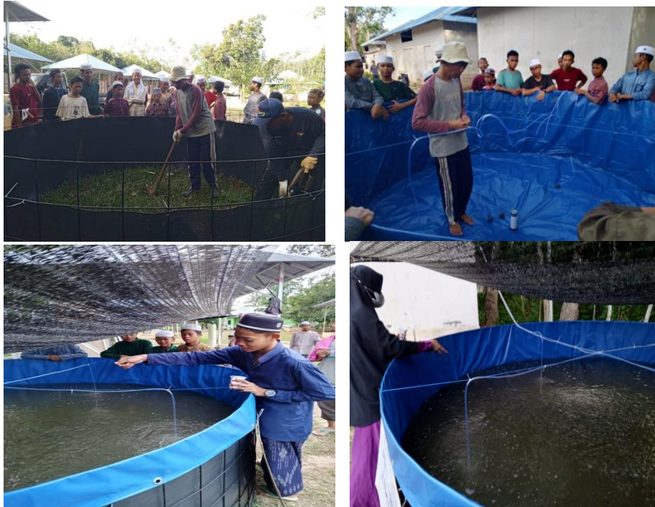
Gambar 2. Pemasangan kolam terpal dengan diameter 3 m dan pengisian air kolam setinggi 60 cm.
