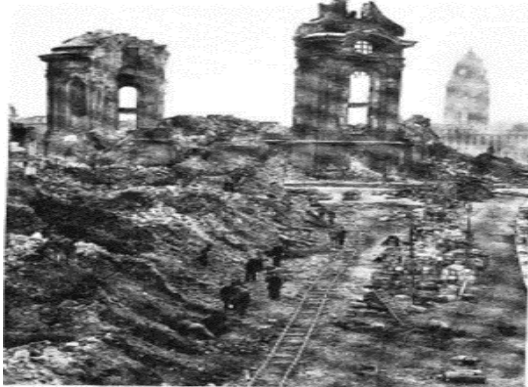
شكل 7 تشكيل سلاسل بشرية ومسارات لتمرير الحجارة القابلة للاستخدام إلى نقطة تجميع معينة. المصدر [31]
