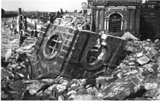
شكل 6 الأحجار التي تم إنقاذها وإعادة استخدامها في إعادة الإعمار المصدر: [28]
