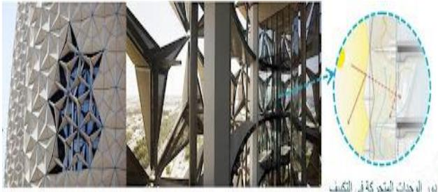
شكل ١٥: يوضح الوحدات المتحركة المكونة لنظام الغلاف دورها في التكيف Karerber 2015
