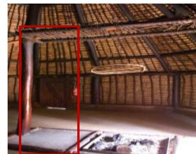
الشكل (33) للعمود المركزي للكوخ التقليدي
