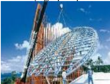
الشكل (31) السقف العلوي قبل التغطية eVXEy/2u.pw//:https
