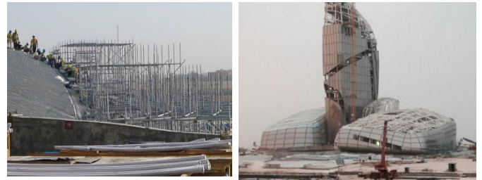
الشكل (79) الهيكل الفولاذي للمبنى الشكل (80) المبنى مرحلة الإنشاء https://www.ft.com/ https://www.ft.com
