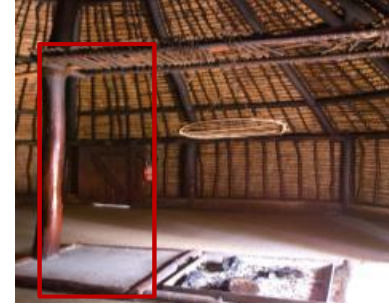
الشكل (33) للعمود المركزي للكوخ التقليدي yYJg/2u.pw//:https
