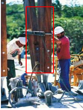
الشكل (28) الخامة الأساسية المستخدمة في هيكل المبنى yYJjg/2u.pw//:https
