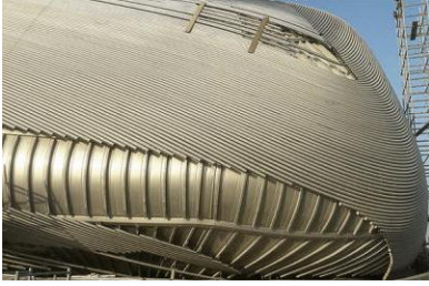
الشكل (81) صورة خارجية لغللاف المبنى لتوضيح الطبقتين الرئيسيتان https://www.ft.com
