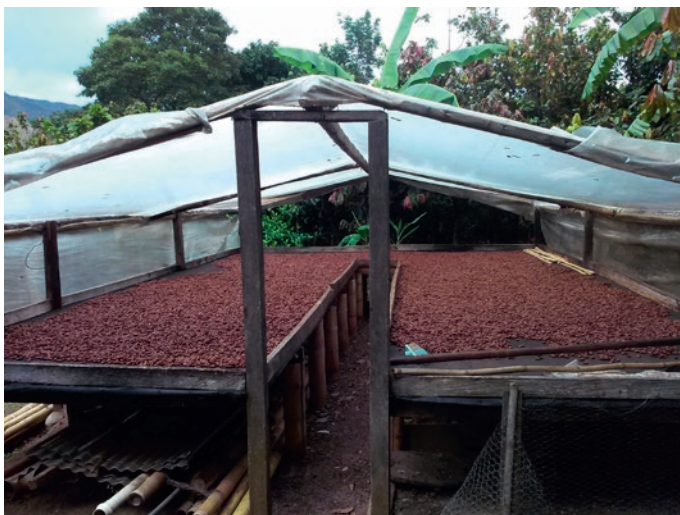
Figura 23b. Marquesina de secado tradicional. Fuente: Leidy Machado Cuellar.
