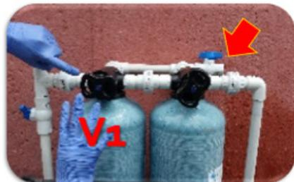
3. Después ajuste la misma válvula V1 hacia arriba (en fast wash) para enjuagar durante aproximadamente 7 minutos siempre verificando que el agua salga cristalina por el tubo ubicado detrás de los filtros, de lo contrario extienda el tiempo de lavado.
