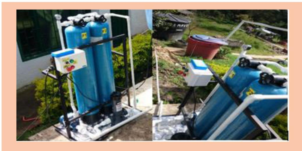
Imagen 13. Fotografías filtros de adsorción implementados en el proyecto.
