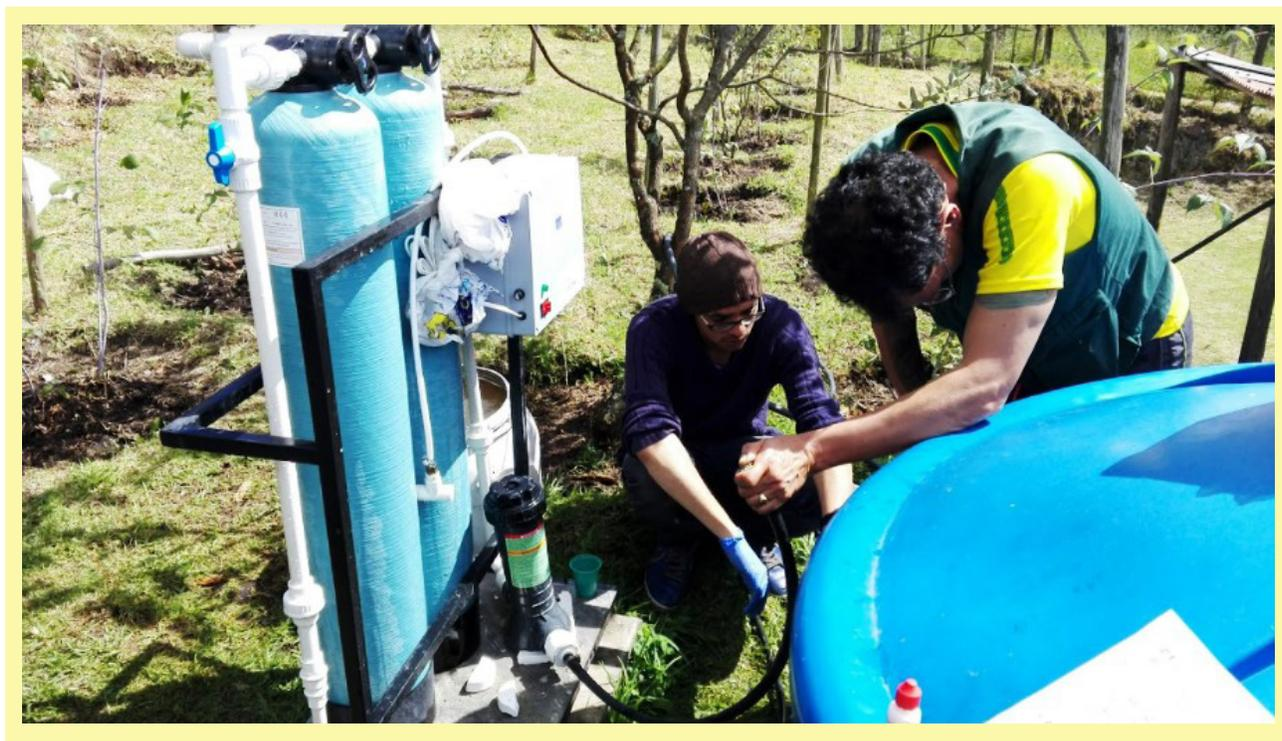
Imagen 3 Fotografía de mantenimiento preventivo de sistema de filtros de adsorción.
