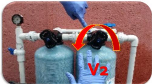
5. Repita el proceso con la válvula V2 negra (de la derecha) girándola hacia la izquierda para retro lavar (en back wash) alrededor de 7 minutos hasta que el agua salga cristalina por el tubo ubicado detrás de los filtros.
