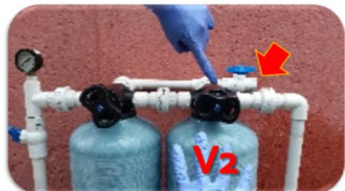
6. En seguida ajuste la válvula V2 hacia arriba (en fast wash) para enjuagar durante aproximadamente 7 minutos siempre verificando que el agua salga cristalina por el tubo ubicado detrás de los filtros, de lo contrario extienda el tiempo de lavado.
