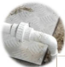
A. Inicie lavando los tanques con agua y jabón, puede desenroscar los acoples universales para mayor comodidad ( debe realizar esta labor cada 2 meses).
