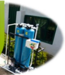
B. Verifique que la tubería no tenga fugas ni goteras, de ser así utilice teflón o soldadura de pvc para reemplazar la pieza afectada o sellar el escape.
