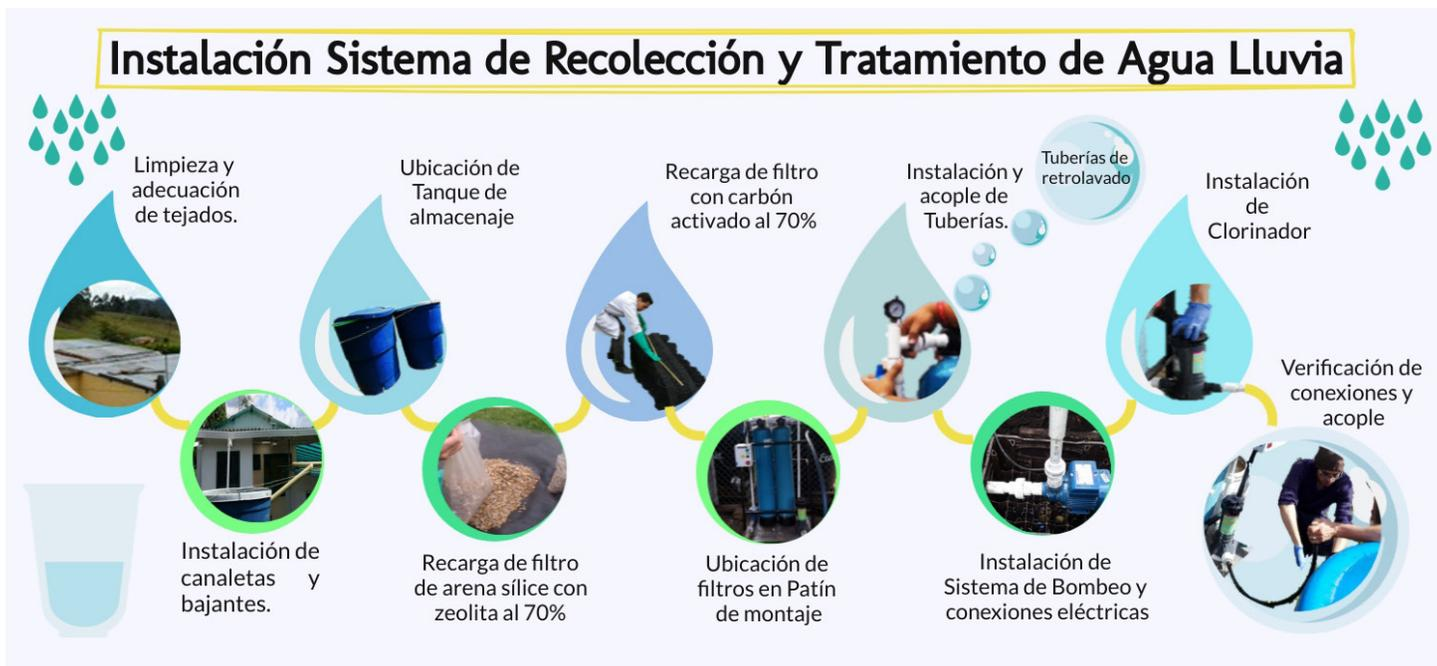
Figura 8. Procedimientos de implementación de sistemas de captación y tratamiento de agua lluvia.
