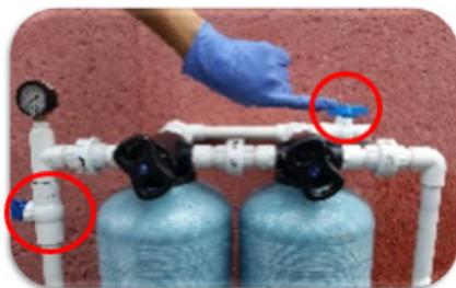
1. Antes de encender el sistema, verifique que todos los registros (válvulas azules) estén abiertas (en la misma dirección de la tubería).
