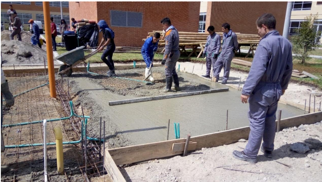
Figura 26. Vaciado de concreto
