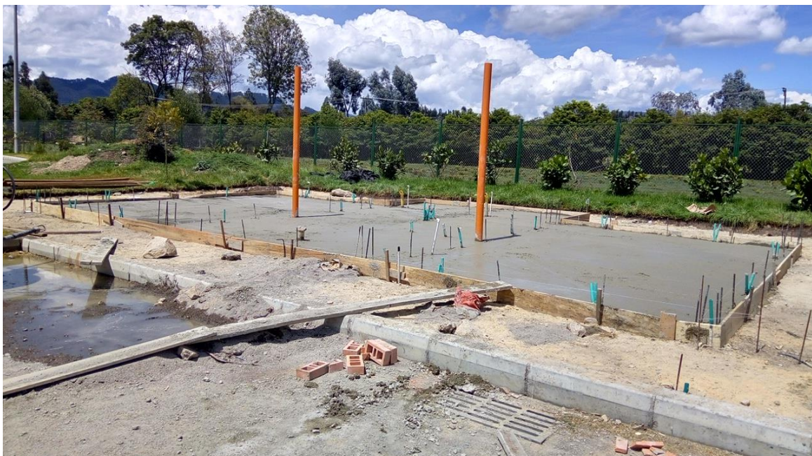
Figura 29. Placa de Concreto terminada con un espesor de 10 cms.
