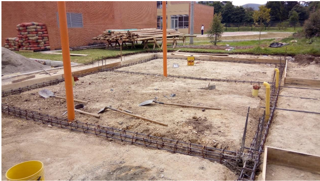
Figura 23. Instalación de malla electro soldada.
