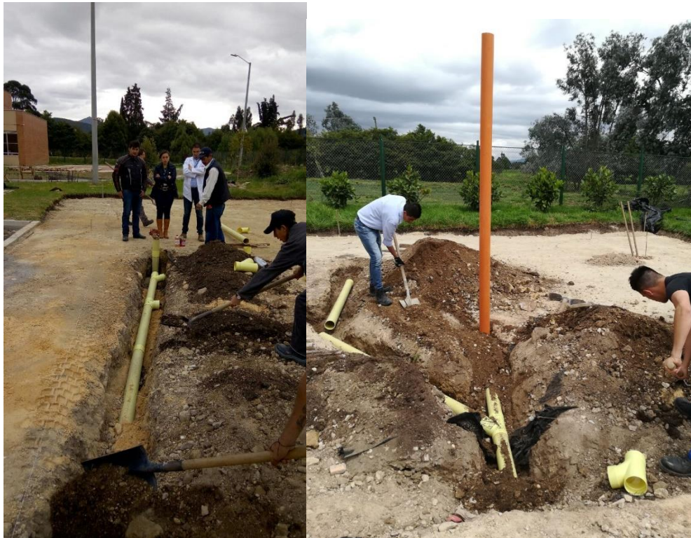
Figura 22. Instalación de red de acueducto y alcantarillado
