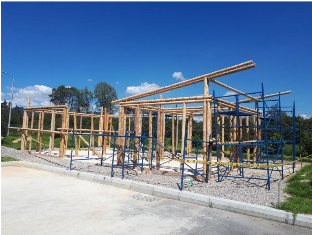
Figura 31. Armado de vigas para techado
