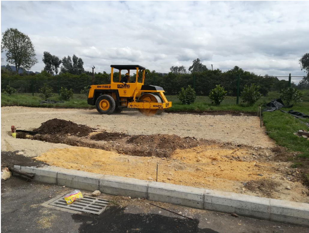
Figura 20. Compactación con vibro compactadora
