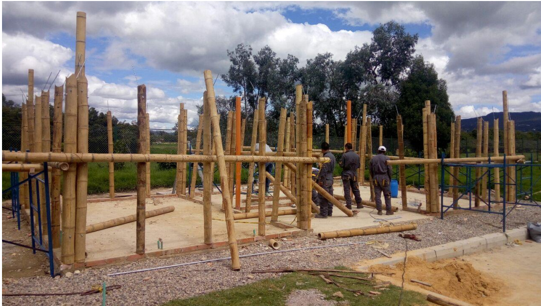
Figura 30. Armado de paredes de Guadua, instalación de columnas.
