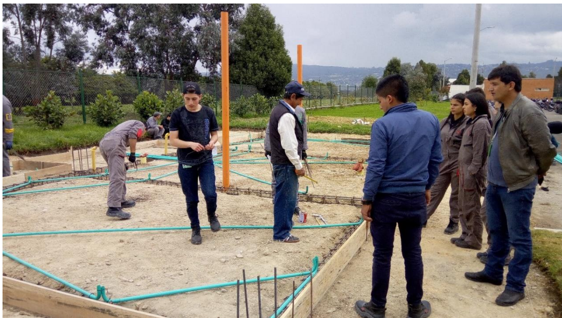
Figura 24. Instalación de red eléctrica
