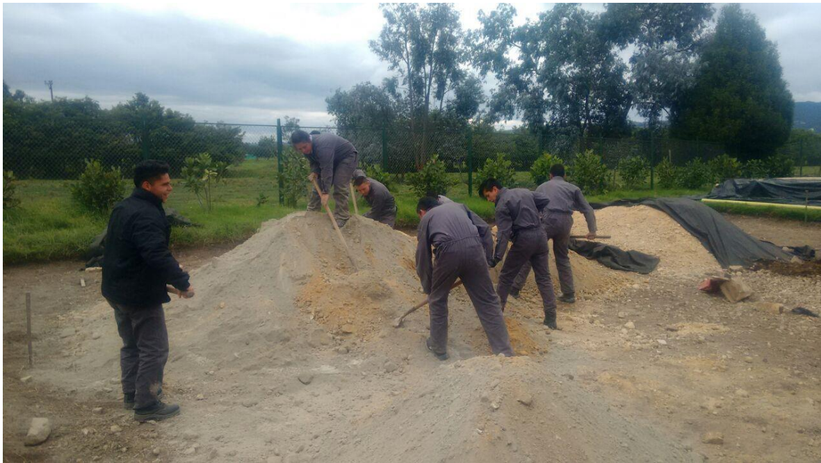
Figura 19. Mezcla para cimentación
