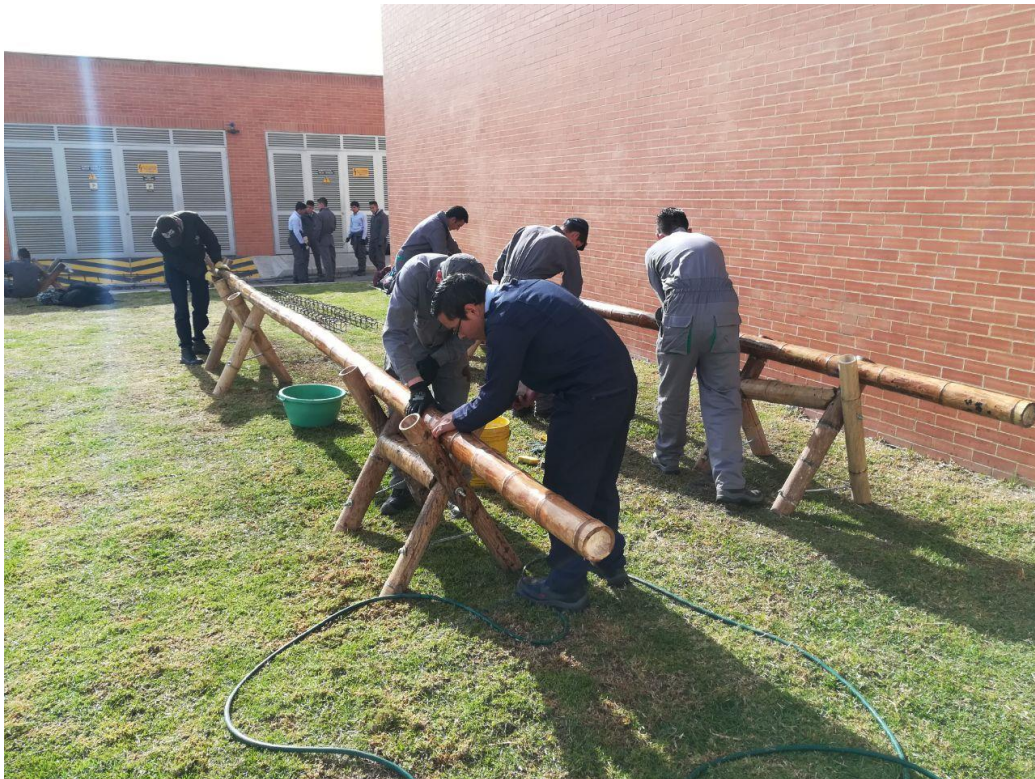
Figura 27. Trabajo de la guadua, limpieza e inmunización.
