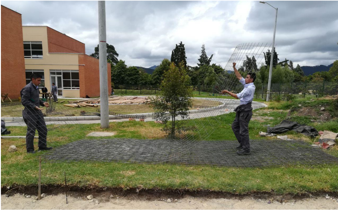
Figura 25. Instalación de malla grafilada para piso
