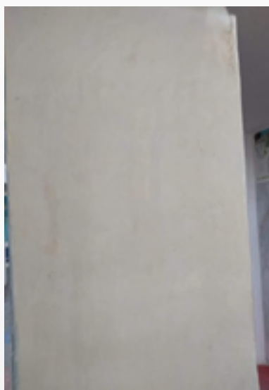
Imagen 1. Muro de ensayo para la aplicación del estuco tradicional con yeso reciclado.
