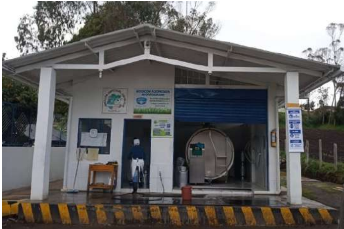
Figura 4. Planta de Acopio y Enfriamiento de leche. ASOVIGUASAR, 2014
