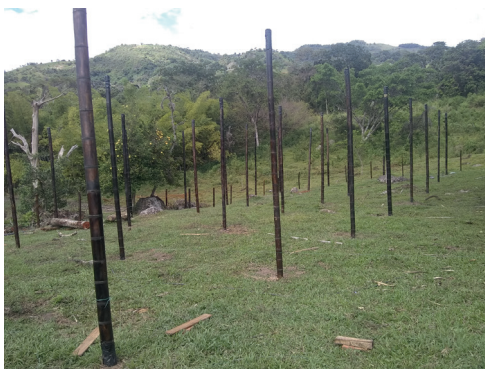
Figura 11. Estructura de Base de la Cubierta Superior
