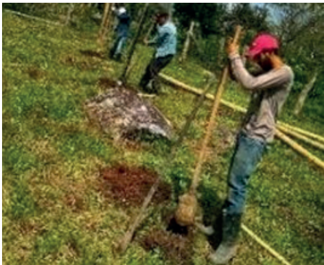
Figura 10 a. Ahoyado para Vigas de Soporte Estructural
