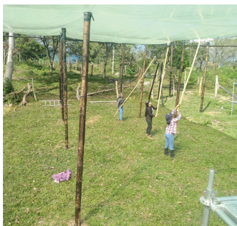
Figura 13 b. Despliegue del Plástico de la Cubierta Superior
