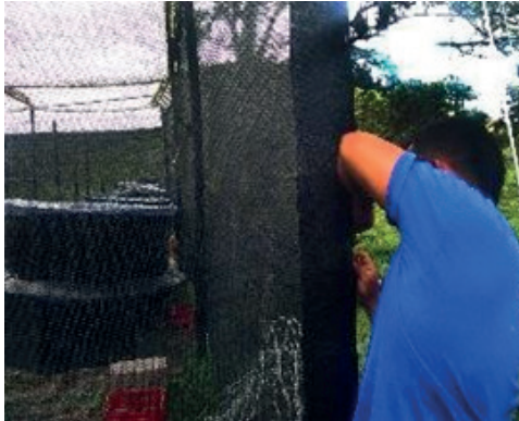
Figura 14 a. Tensionado de Polisombra Lateral
