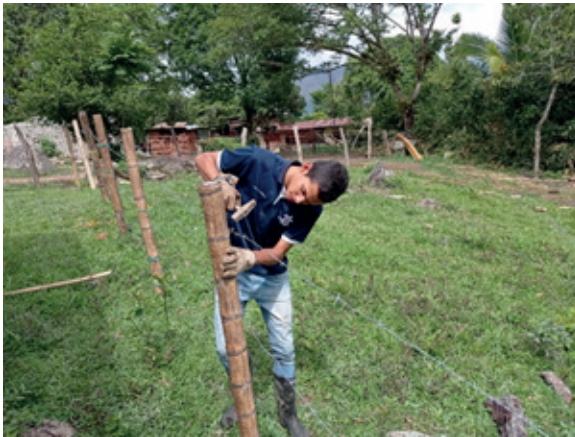
Figura 4. Instalación Alambre de Púas
