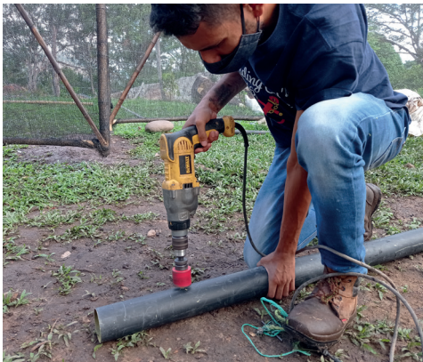
Figura 22 b. Perforación de Tubos Hidropónicos
