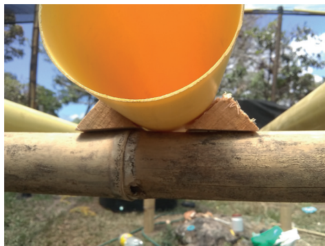
Figura 20 b. Cuñas de Anclaje
