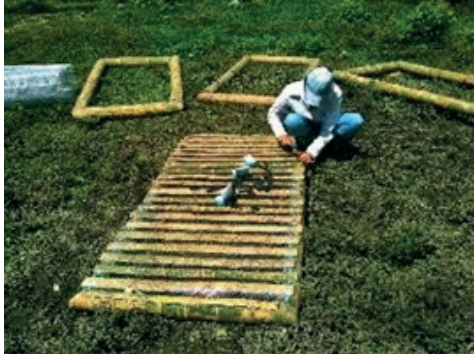
Figura 29 a. Ensamblaje de Bases Modulares
