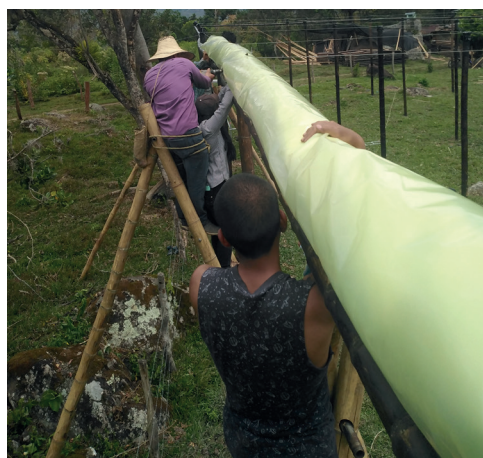
Figura 13 a. Distribución del Plástico en la Cubierta Superior
