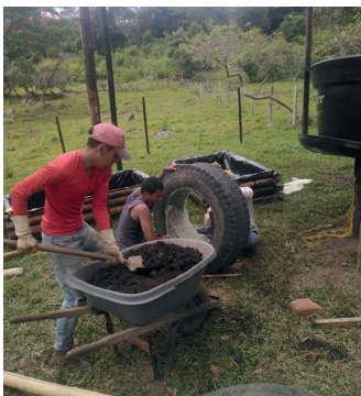
Figura 15. Plataforma para el Soporte de Estanques
