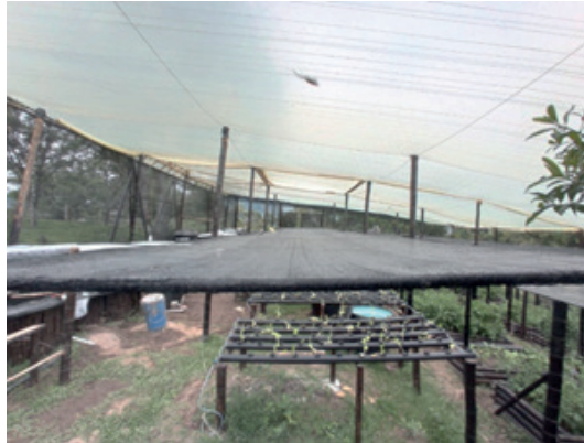
Figura 34. Pantallas Deflectoras de Calor
