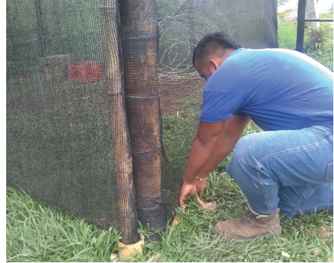
Figura 14 b. Tensionado de Polisombra Vertical
