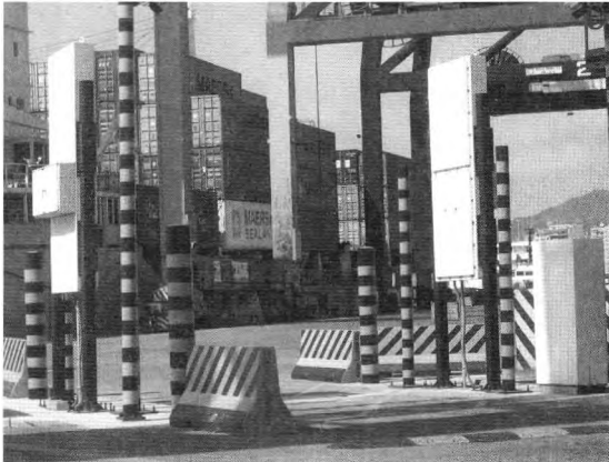
Instalaciones Megaport en el Puerto Bahía de Algeiras. Fuente: APBA
