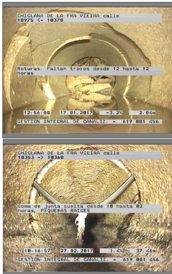
Figura 9: Inspección de tuberías de redes pluviales en la calle Vieira mediante cámaras.
