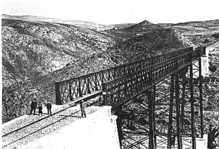
Fig. 1. Viaducto sobre el río Golmayo. Ferrocarril Torralba-Soria (1892).
