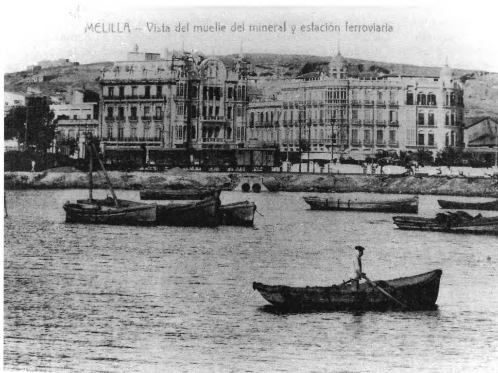
Vista del muelle del mineral y estación ferroviaria (col. Foto Soria)
