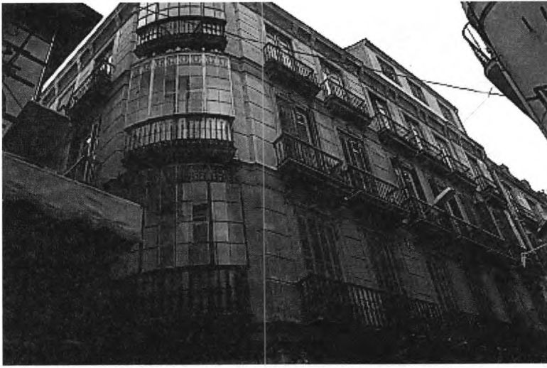
Edificio de viviendas en calle Sánchez Pastor n.º 1. E. Strachan
