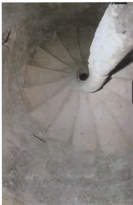
Fig. 27. Nabo helicoidal en la escalera de caracol, probablemente para permitir el paso de las maromas para el tañido.
