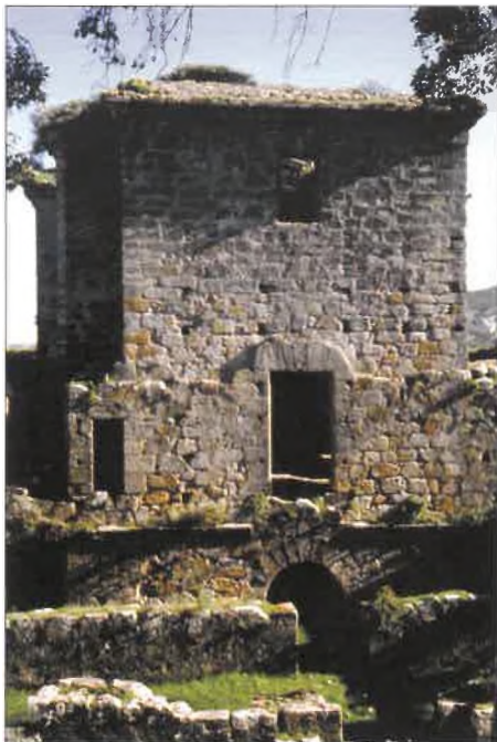
Fig. 9. Detalle de la fachada NE mostrando los pies de la Iglesia con el acceso ultrasemicircular a la cripta y cuadrangular a la nave principal.
