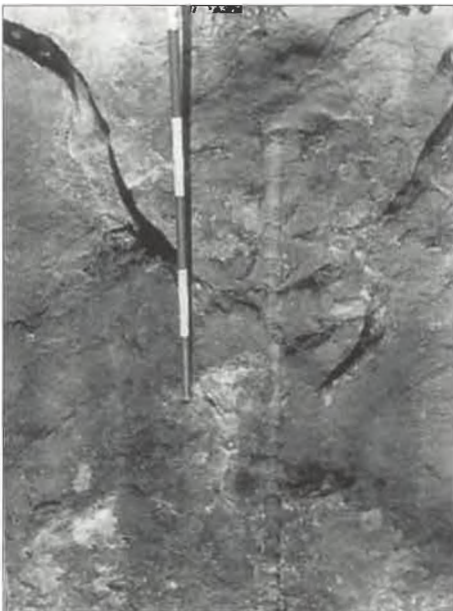
Fig. 63. Huella de uno de los barrenos utilizados en las voladuras del Padre Acisclo de San Rafael durante la construcción del monasterio.
