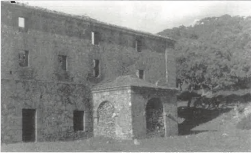
Fig. 11. Primer plano del zaguán porticado en la fachada NW.
