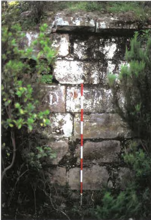
Fig. 58. Costado NW. Dintel monolítico con falso despiece de sillería engatillada y arco de descarga escarzano con rosca de un pie de ladrillo.
