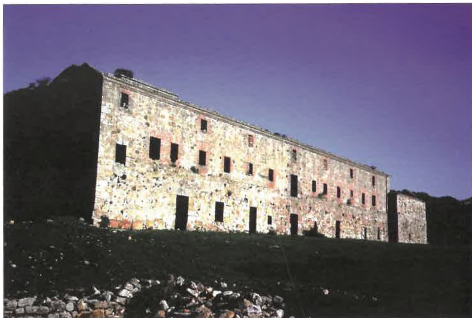
Fig. 3. Fachada SW del Monasterio.
