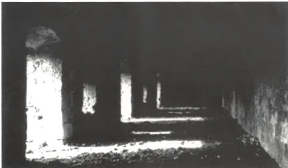
Fig. 17. Cámaras inferiores destinadas a uso común.
