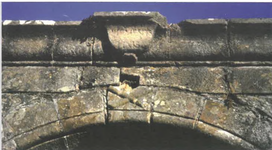
Fig. 29. Clave del arco exterior del zaguán, en la esquina NW del Monasterio, con la simbología fúnebre habitual en los Desiertos. En el canecillo aparece el aforismo “memento finis”, y debajo las dos tibias cruzadas y el hueco donde, en su día, estaba la calavera.
