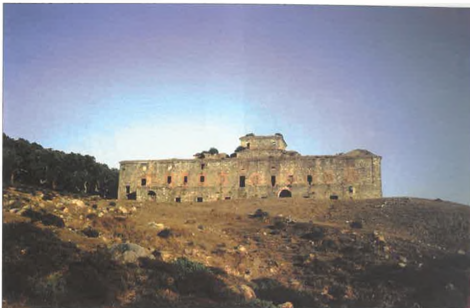
Fig. 5. Fachada NW del Monasterio. A la izquierda se percibe la estructura avanzada del zaguán.
