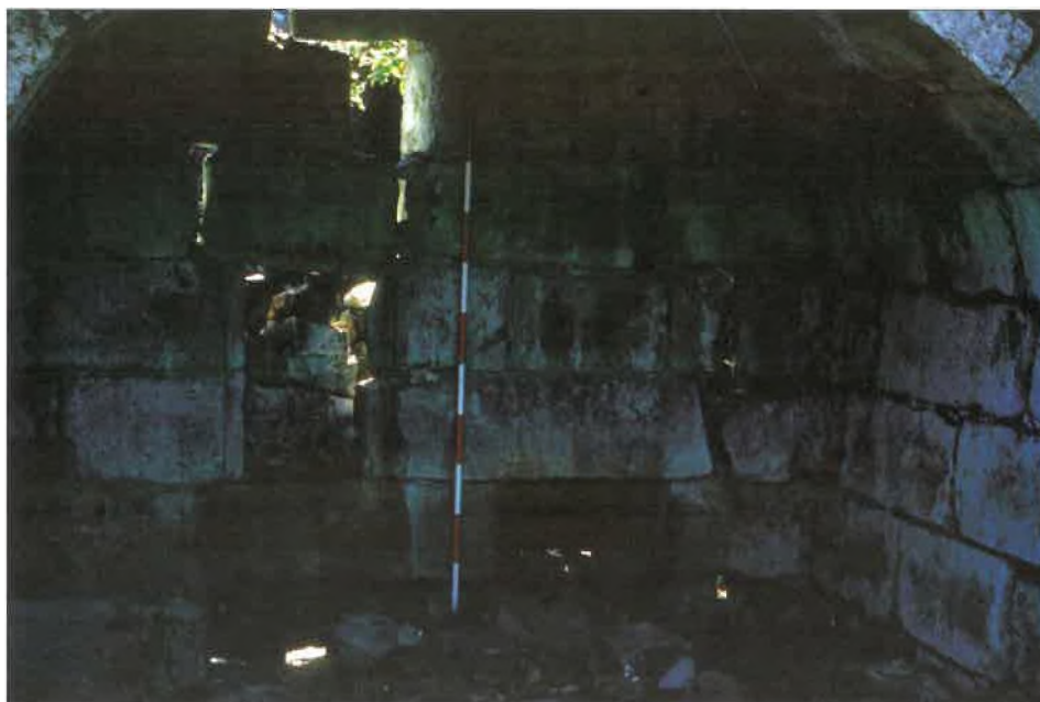
Fig. 49. Cubículo de la chimenea en la ermita octogonal mejor conservada en la ladera poniente.
