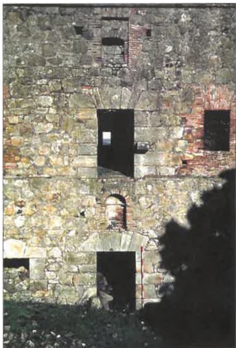
Fig. 7. Detalle de la fachada SE desde el nivel del suelo. La ventana de la izquierda tapada a la mitad alojó una capilla en su momento. Conserva una hornacina.
