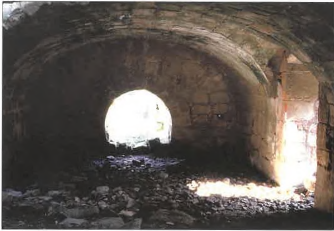
Fig. 20. Arco semicircular de acceso y cripta, desde el crucero.
