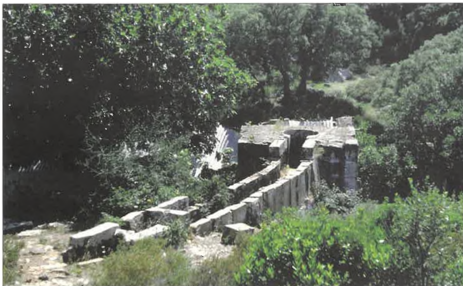
Fig. 56. Cao de alimentación del cubo del molino de El Cuervo en la margen del río Celemín, construido entre 1757 y 1760 reproduciendo una estructura similar caída en 1716.
