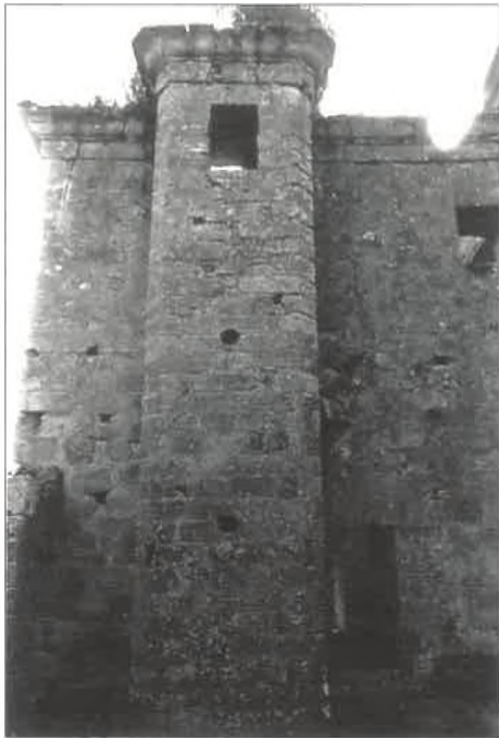
Fig. 12. El cuerpo de la escalera de caracol en el exterior del costado septentrional de los pies de la iglesia.
