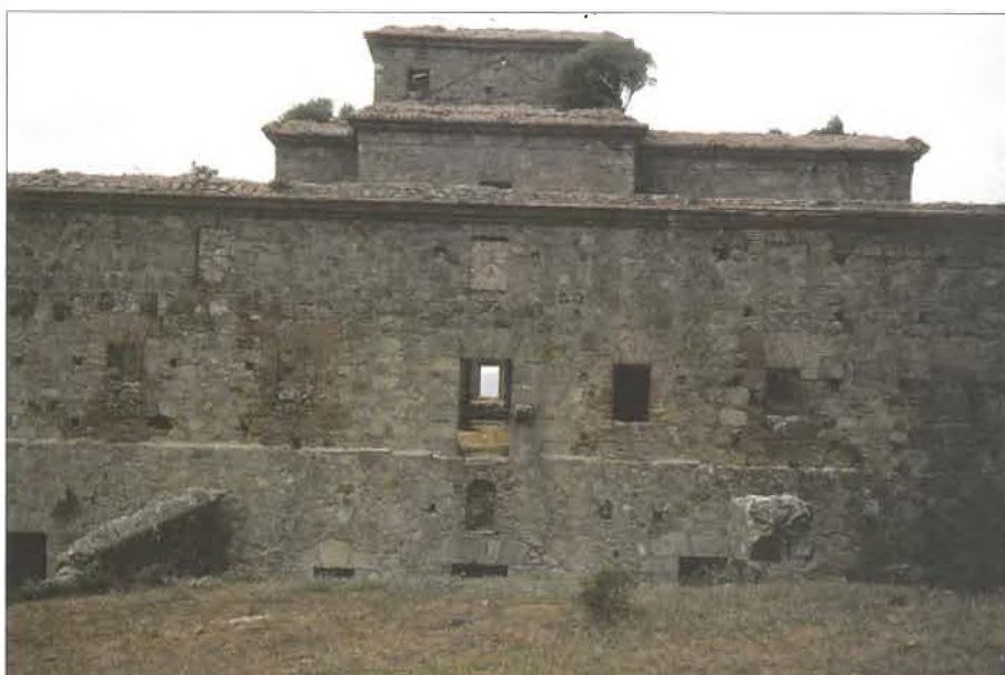
Fig. 6. Centro de la fachada SE del Monasterio a la altura de la planta de la Iglesia.
