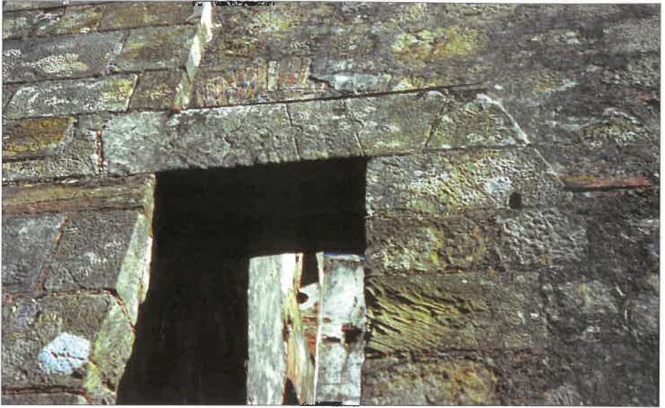
Fig. 58. Costado NW. Dintel monolítico con falso despiece de sillería engatillada y arco de descarga escarzano con rosca de un pie de ladrillo.
