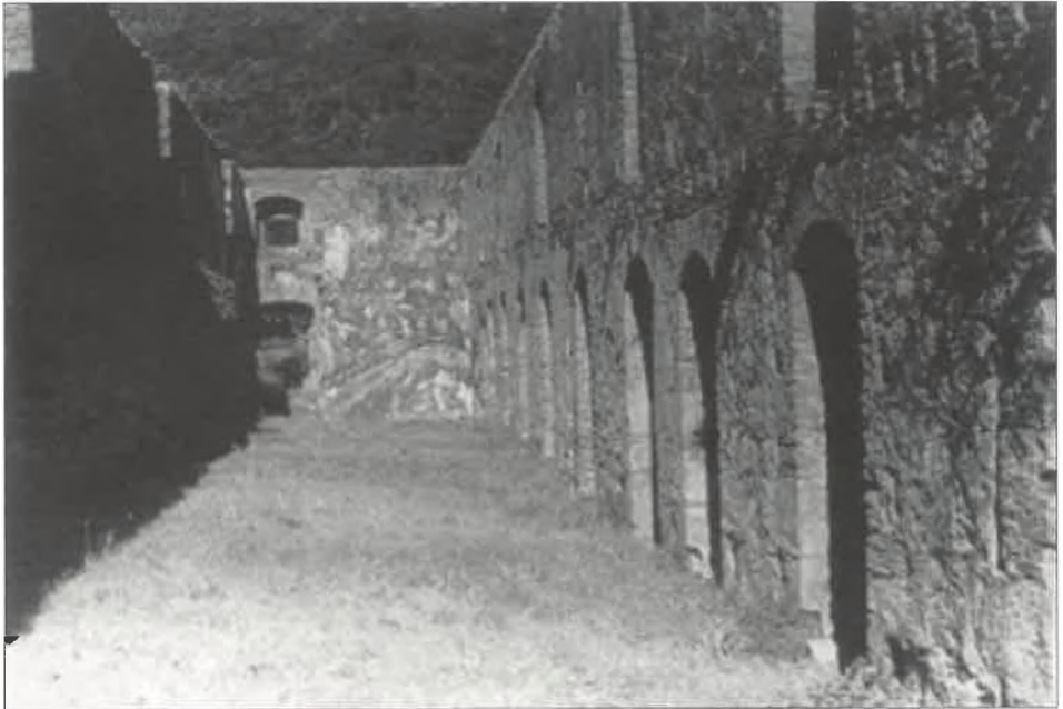
Fig. 16. Estructuras internas mostrando las huellas de las crujeas perdidas.
