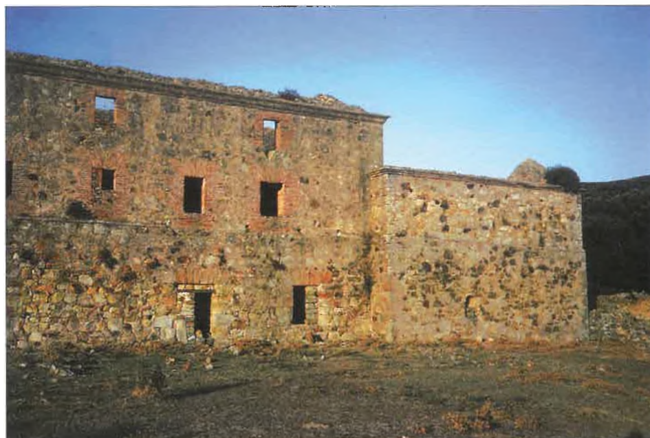
Fig. 4. Extremo meridional de la fachada SW, mostrando el entronque del oficio humilde.
