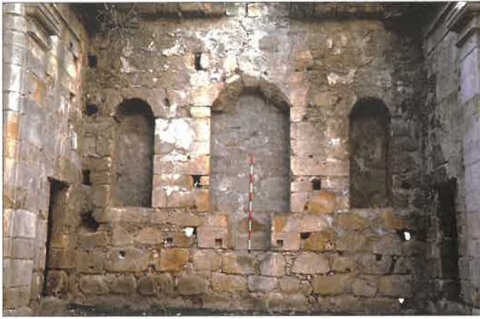
Fig. 22. Cuerpo inferior de las tres calles de hornacinas para el retablo. A ambos lados los huecos de sendas tacas.
