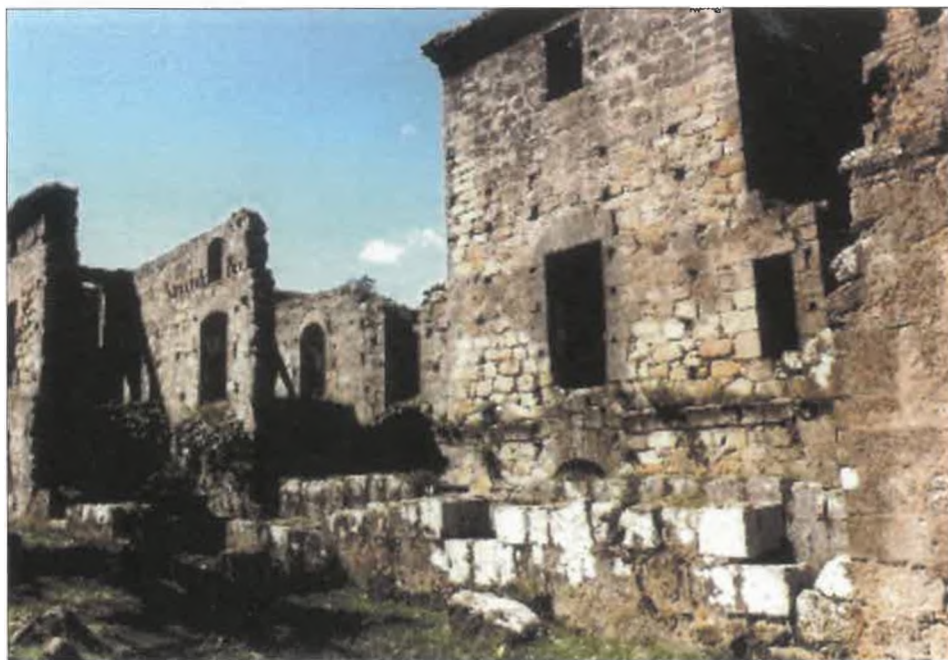
Fig. 8. Fachada NE mostrando la cruzja inacabada y los pies de la iglesia.
