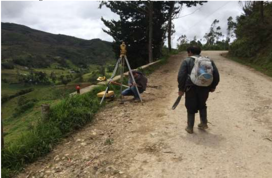
Imagen N° 2.19: Levantamiento topográfico Inicio de carretera
