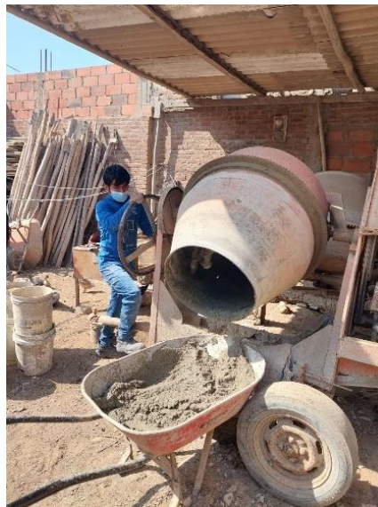
Imagen 10: Mezcla del Concreto celular. Fuente: Elaboración Propia.
