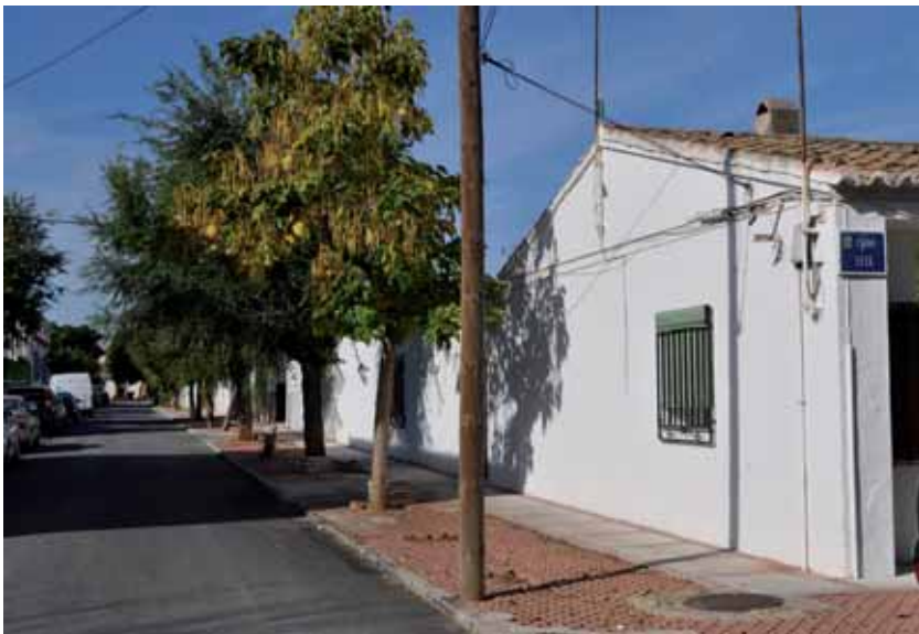
Figura 7: Viviendas de colonos de Ampliación de Espelúy. Fuente: autores
