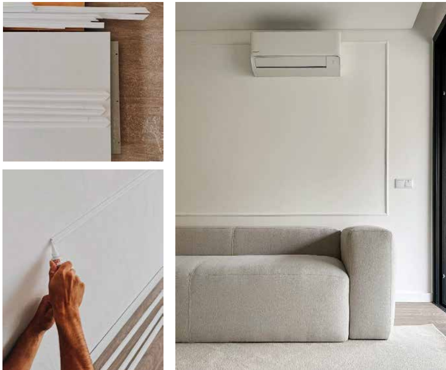
Fig. 181, 182, 183 Registos fotográficos: cortes em meia esquadria do perfil, respetiva aplicação e o resultado obtido. Fonte: FBN.
