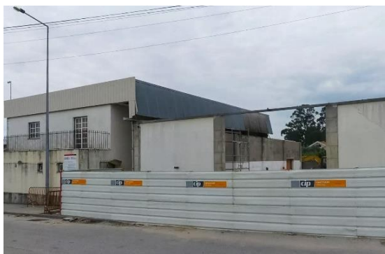
Fig. 193 Reabilitação do Edifício Municipal. Fonte: CMTábua
