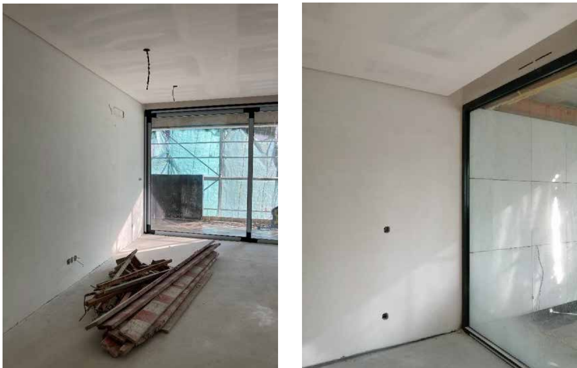
Fig. 160, 161 Registos fotográficos do apartamento em fase de obras. Fonte: Autora.
