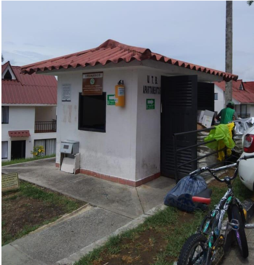
Fotografía 14. Shut de basura, parte alta del conjunto residencial Cañaveral II, Fuente Propia
