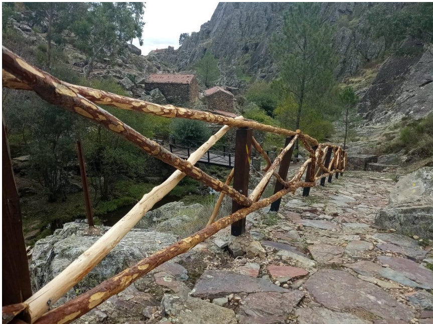
Figura 15. Corrimão construído com material madeira (Créditos: Nicole Marques).
