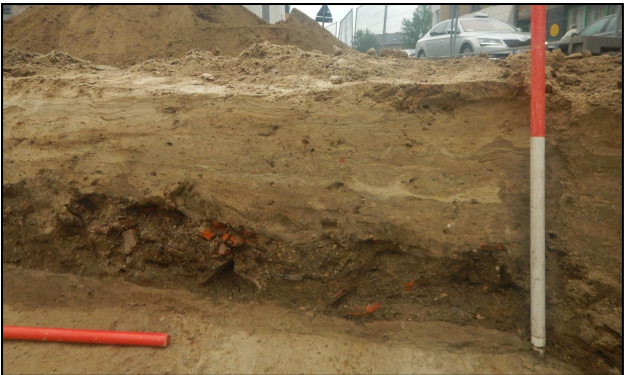
Figuur 72: detailfoto van het bovenste deel van wegtracé S19 met een fijne golvende gelaagdheid van opeenvolgende fasen aangelegd en gecompacteerd lichtgrijs zand. Binnen deze eerste fase zijn ook duidelijk meerdere aanlegfasen (minstens 4, mogelijk 5) te zien waarin ook karrensporen te zien zijn.
