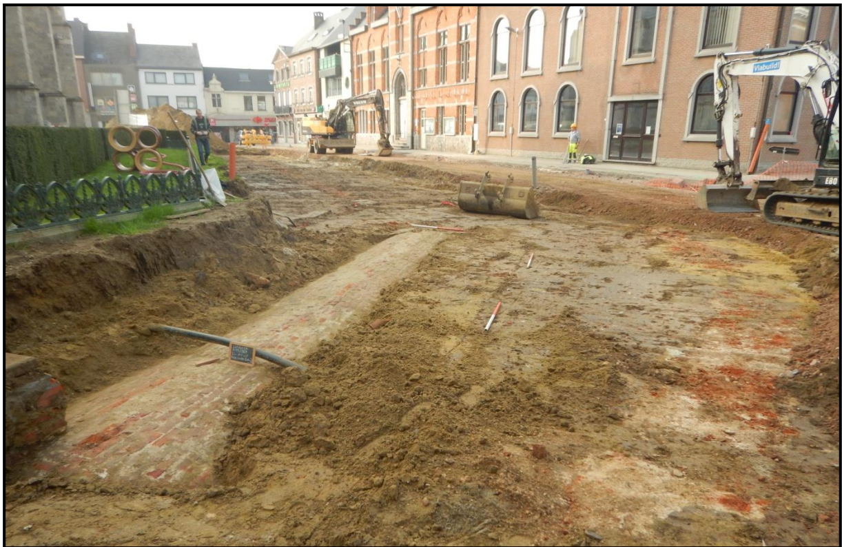
Figuur 189: Links de rechthoekige overwelfde bakstenen regenwaterput die in 1893 ten noordoosten van de kerk werd gebouwd. Rechts de bovenkant van de bakstenen kerkhofmuur.
