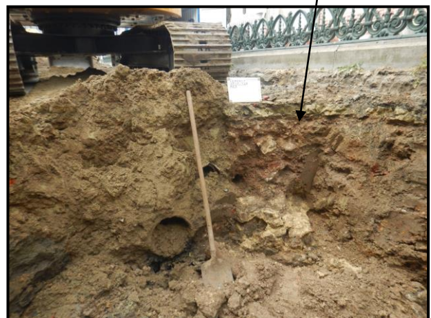
Figuur 174: Eveneens ten zuidoosten van de kerk werd tijdens de werfbegeleiding onder de oude riolering een stuk van de romaanse kerkhofmuur volledig in Leedse steen herkend.
