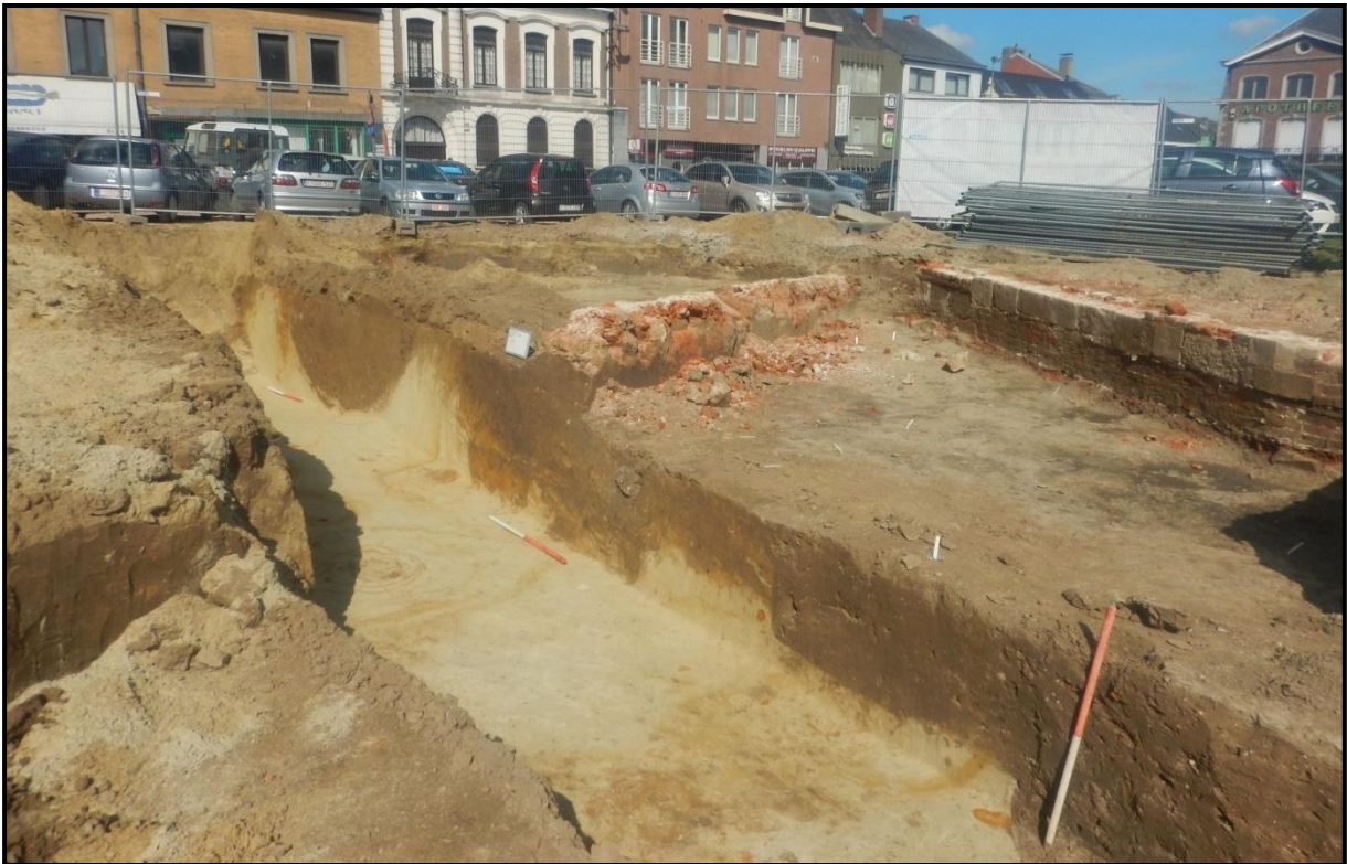
Figuur 57: Zicht vanuit het zuidoosten op Profiel 5, het noordprofiel in de sleuf die aangelegd voor de nieuwe riolering.
