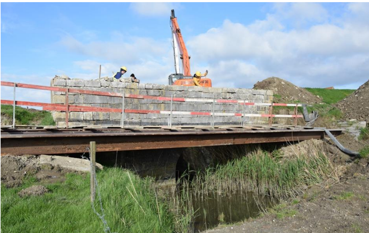
Figuur 8: De kopmuur in natuursteen aan de noordoostkant van de Hazegrassluis, met onder de stelling de overdekte sluisgang met tongewelf. Het archeologisch onderzoek is in uitvoering achter de kopmuur (Foto: Sofie Vanhoutte).
