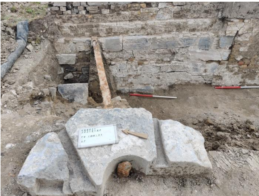
Figuur 25: Detailfoto van anker S7 onder natuursteenblok S3. Het anker zit ingewerkt in de natuurstenen kopmuur S13. Zicht naar het noordoosten (Foto: Monument Vandekerckhove nv).
