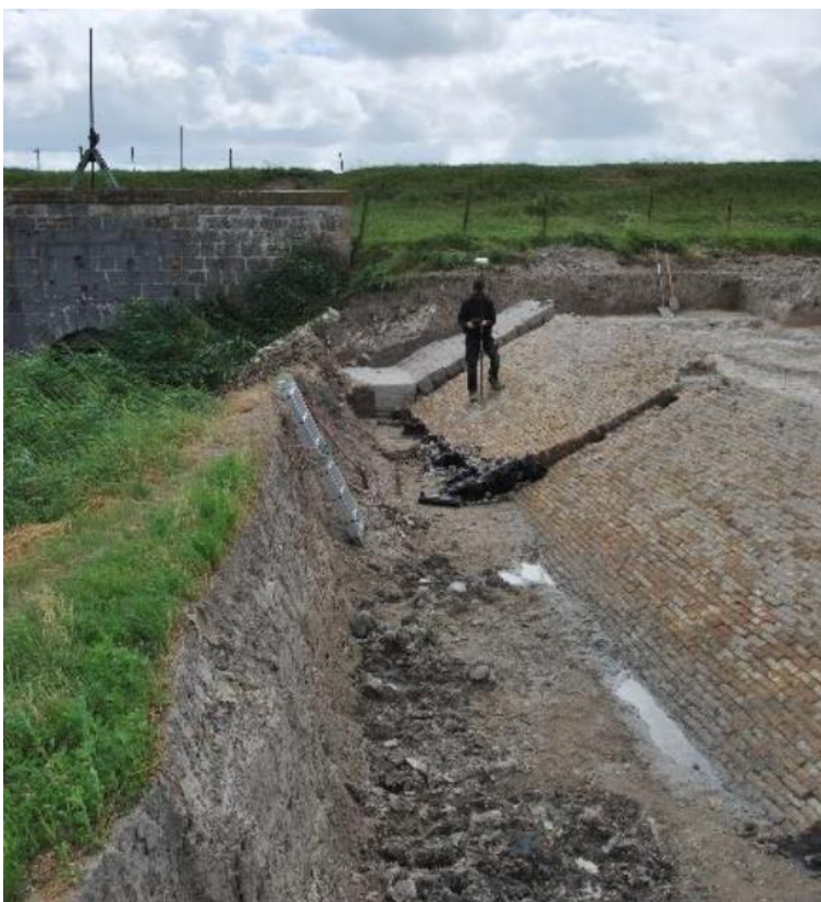
Figuur 33: Zicht op de Hazegrassluis (links) en het aangetroffen dijklichaam met flankerende muren in baksteen en natuursteen ten noordoosten van de Hazegrassluis (© GATE bvba) (uit: Laloo et al. 2019).
