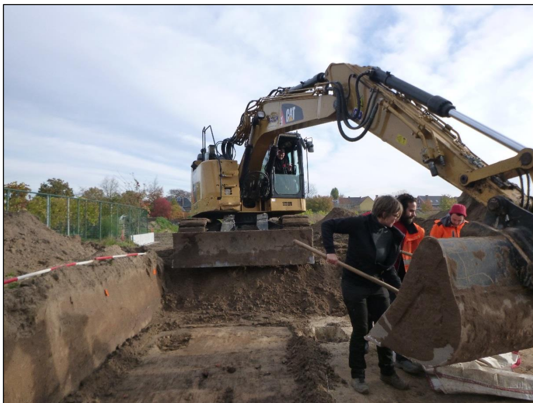
Figuur 9: Werkmethodiek – uitgraven en integraal bemonsteren van de potstal in kwadranten.
