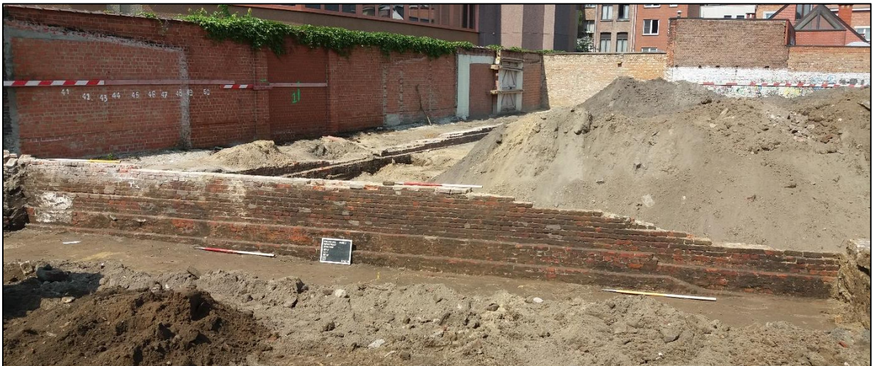
Figuur 51: overzicht spoor 3.27 (bron: Abo nv 2018)
