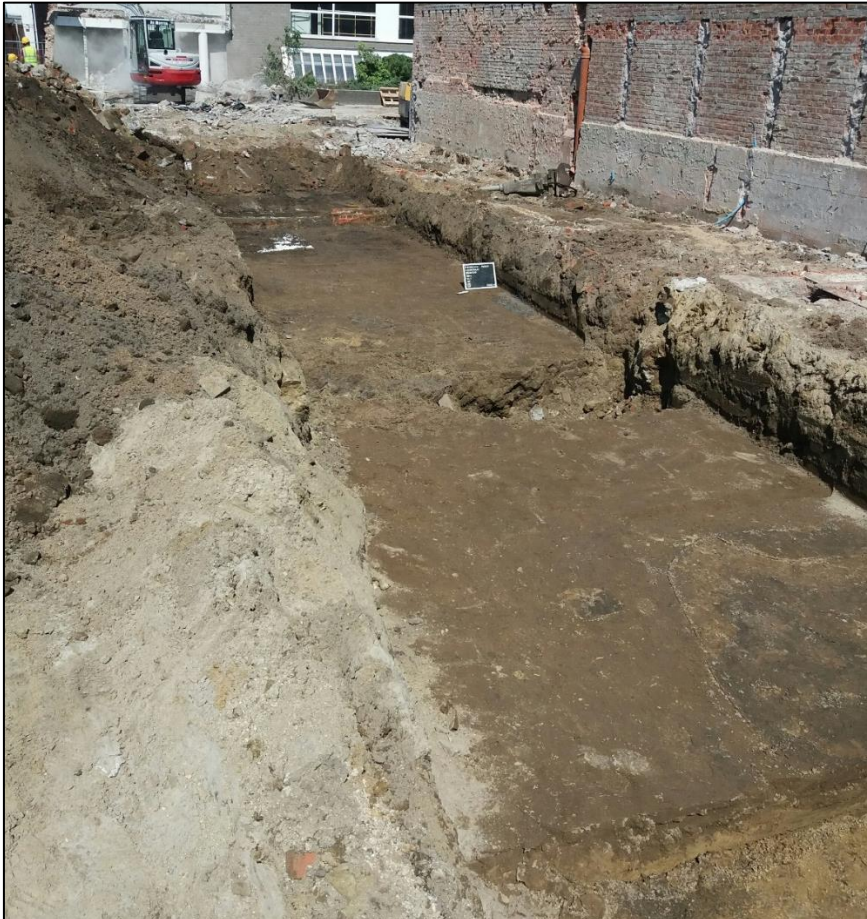
Figuur 100: overzicht vlak 1 WP4 ter voorbereiding onderschoeiing (Abo nv, 2018)
