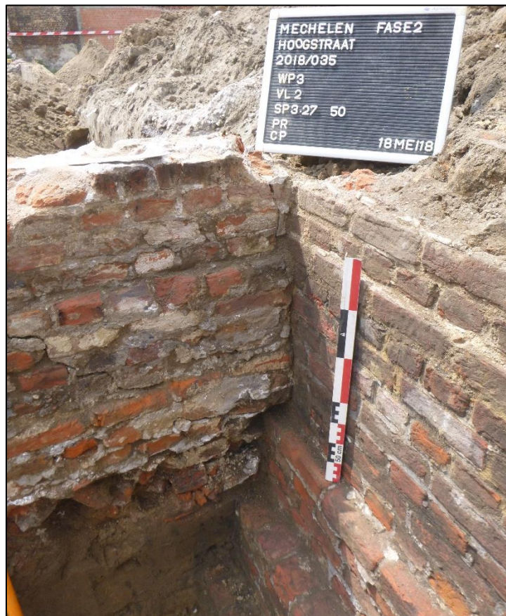
Figuur 80: detail muurwerk hoekverband spoor 3.27 (N-muur) en 3.50 (Z-muur), niet in verband gewerkt (bron: Abo nv, 2018)
