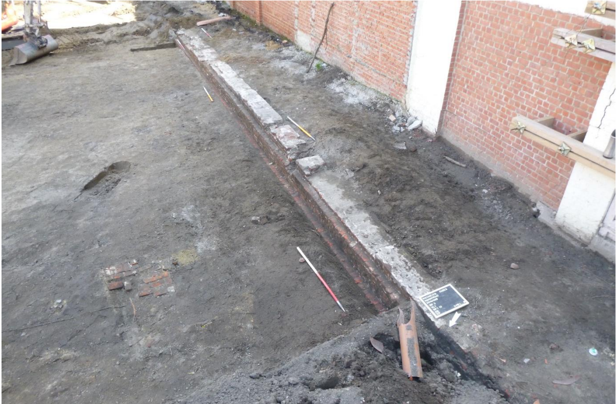
Figuur 46: muur SP1.10 t.h.v. Werkput 2 in zuidelijke richting (bron: Abo nv, 2018)
