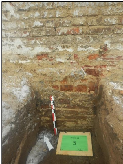
Figuur 25. Fundering bestaande gebouw ter hoogte van WP1
