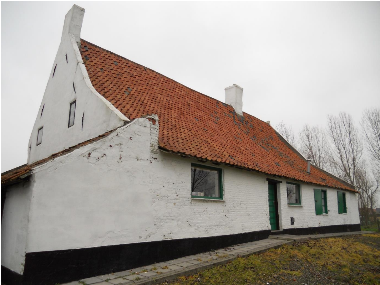
Figuur 5. Overzichtsfoto afgebroken uitbreiding ©Architectenbureau LMS Vermeersch
