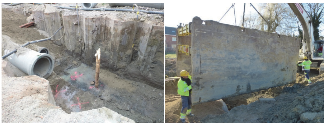
Afb. 4.1. Zicht op de uitgegraven sleuf tussen de damwanden (links) en het gebruik van de rioolbak (rechts).
