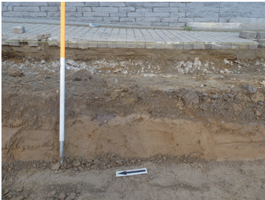
Afb. 4.6. Profiel in het noordelijke deel van de wegeniswerken.
