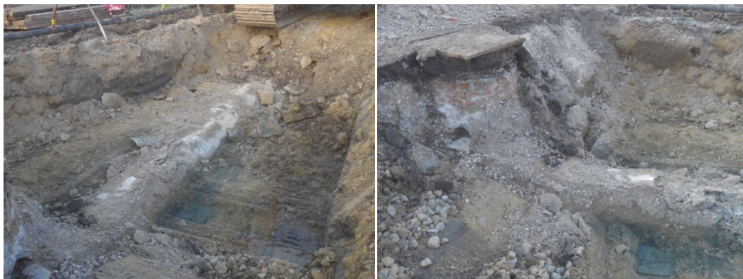
Afb. 4.2. Het uitgraven van de sleuf waarbij de oude riolering werd aangetroffen.
