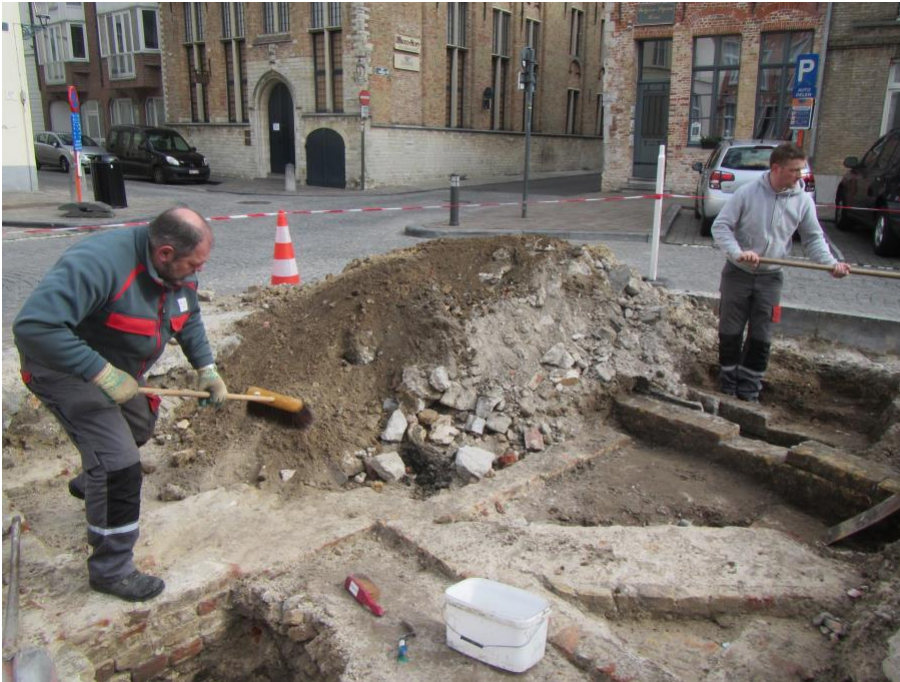
Figuur 11: Sferbeeld met de duidelijk diagonaal geplaatste fundering spoor 10 (© Raakvlak).
