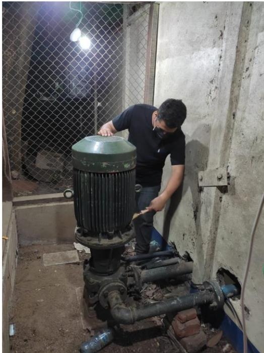
*Figura 41 Preparación del motor y bomba centrífuga antes de la pintura*
