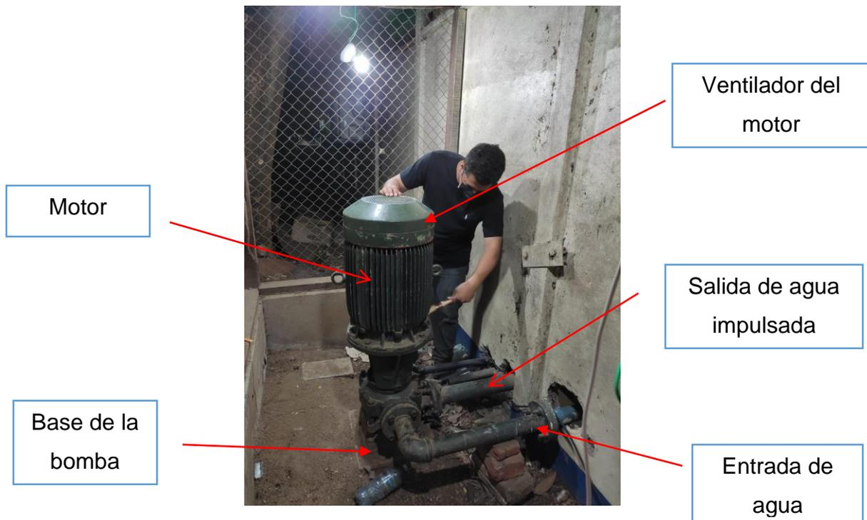
Figura 46: Partes de la bomba
