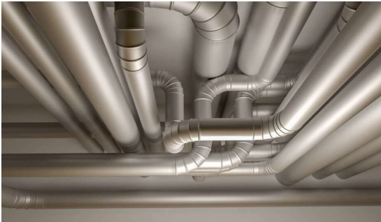
Figura 9 Ducto circular rígido. (Soler Palau, 2020)
