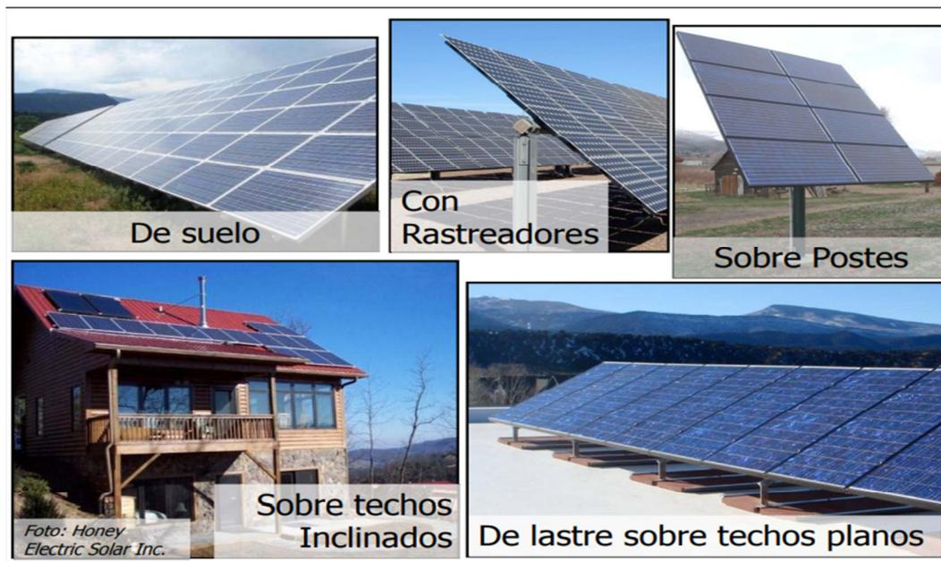
*Ilustración 11 Montaje de Módulos Fotovoltaico*
