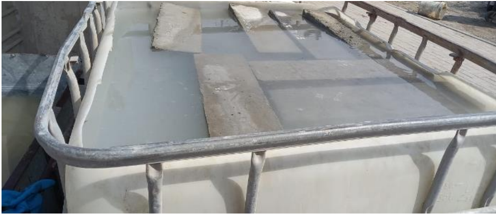
Fig. 36. Curado de vigas
